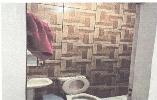
Imagem 10 – Banheiro do Servidor
