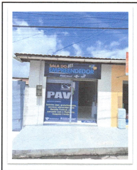
Foto 01: Vista principal do prédio.
