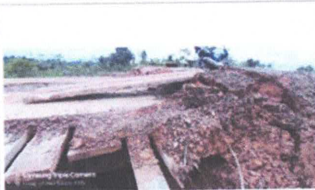
FOTO 03: Ponte na estrada do Cristal
