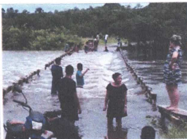
FOTO 08: Ponte do Peritoró Grande
