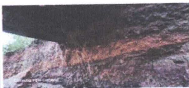
FOTO 01: Ponte na estrada do Cristal
