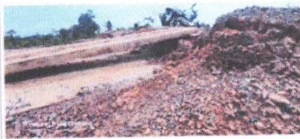
FOTO 02: Ponte na estrada do Cristal
