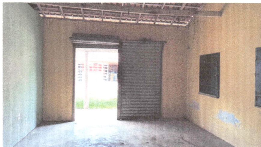
Foto 01: Interior da sala 02.
