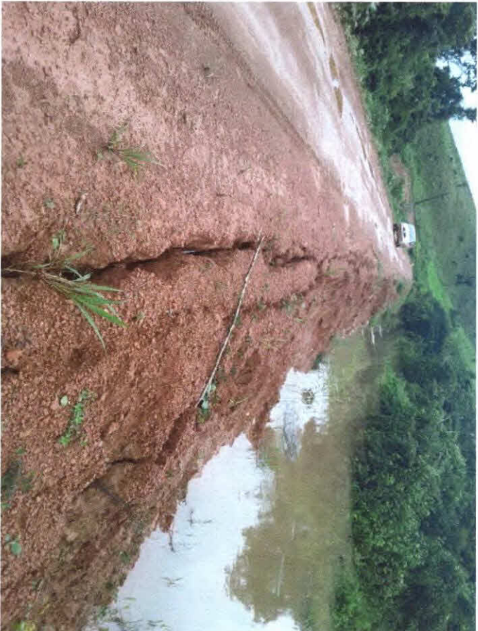
FOTOS 01, E 02: TALUDE DO ATERRO COMPROMETIDO, ESTRADA PRINCIPAL QUE LIGA VILA BRASIL
