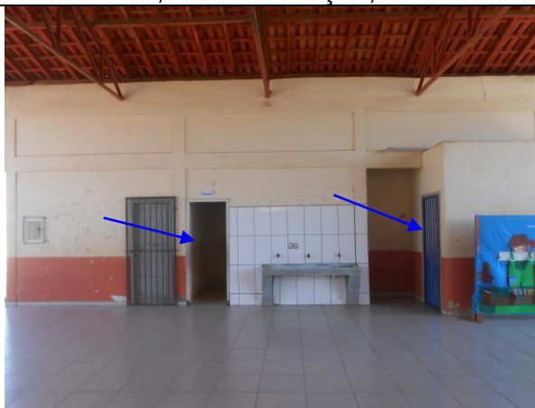
Foto 14 – Banheiros: Feminino, e para PNE.
