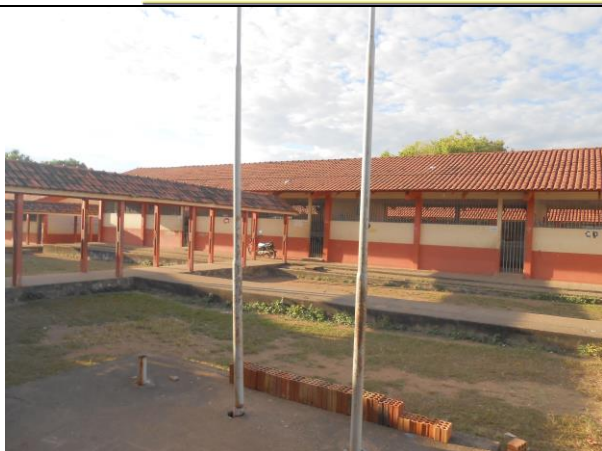
Foto 05 – Blocos da escola – Salas de Aula. Padrão da estrutura.
