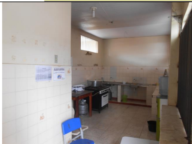
Foto 31 – Copa. Piso cerâmico, parede com parte em azulejo e parte em pintura PVA.
