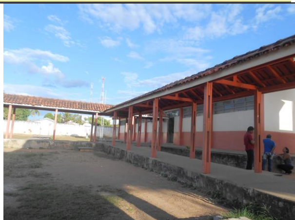
Foto 06 – Cobertura em madeira, telha cerâmica e pilares em madeira.
