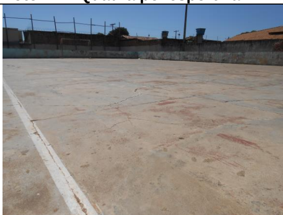
Foto 44 – Piso da Quadra poliesportiva.
