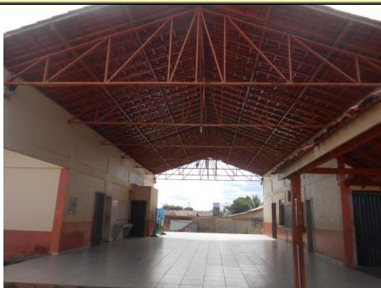
Foto 12 – Bloco recreativo: espaço de convivência, de alimentação, sanitários.
