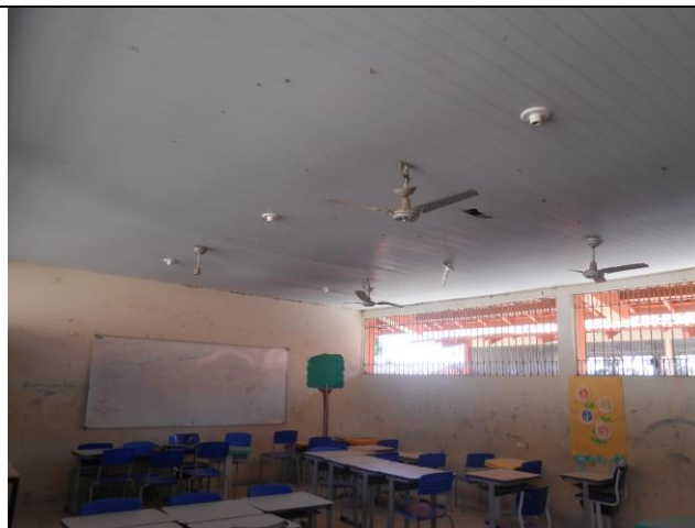
Foto 26 – Outra sala com padrões de acabamentos semelhantes, mas com ventiladores de teto.
