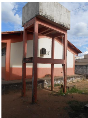
Foto 40 - Reservatório de água.
