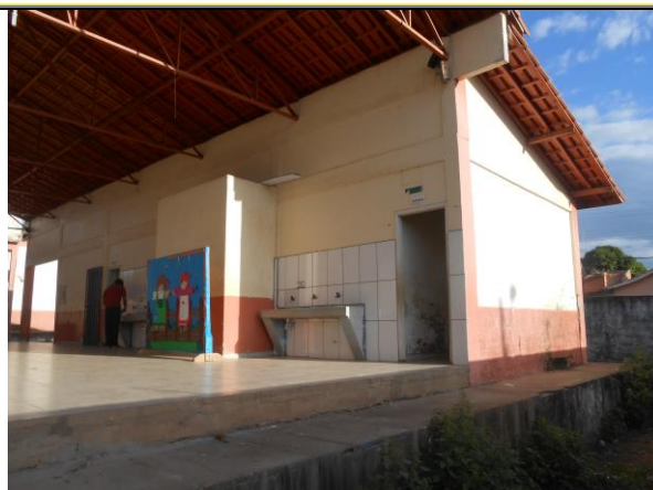
Foto 18- Acesso ao banheiro masculino.
