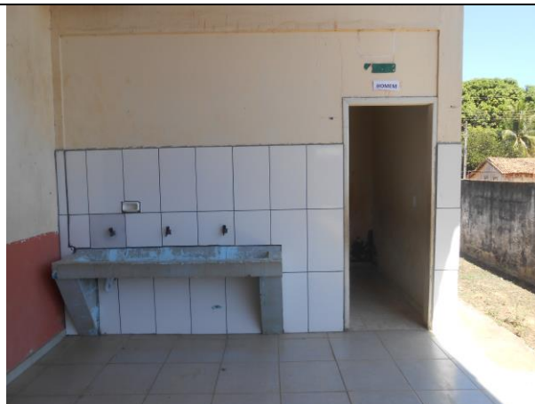
Foto 19 – Lavatório externo e acesso ao banheiro masculino.
