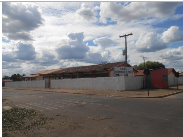
Foto 01 – Fachada Escola Adão Mendes de Abreu – Antigo Marizete. Avenida 10 esquina com Rua 01.
