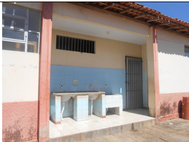
Foto 34 – Área de serviços, piso e parede com revestimento cerâmico. Tanque com tres bacias.
