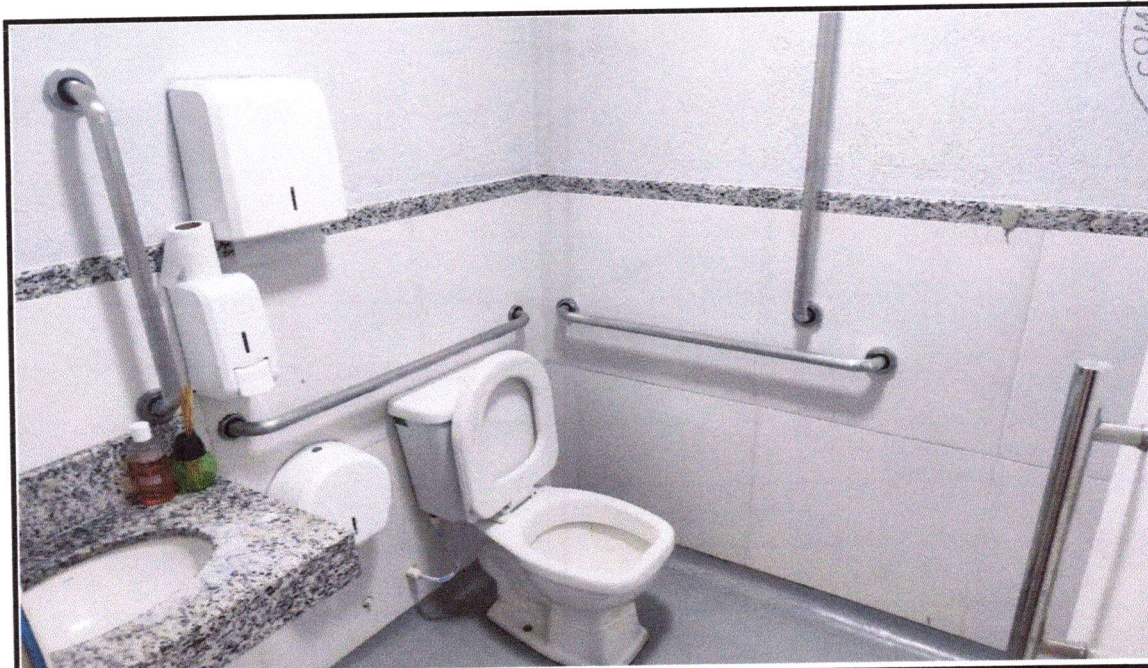
Foto 05: Banheiro feminino adaptado no térreo, atendendo às normas de acessibilidade.
