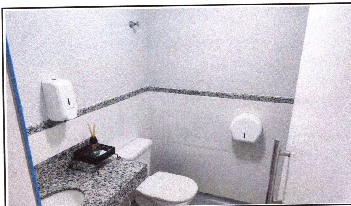
Foto 06: Banheiro masculino no térreo
