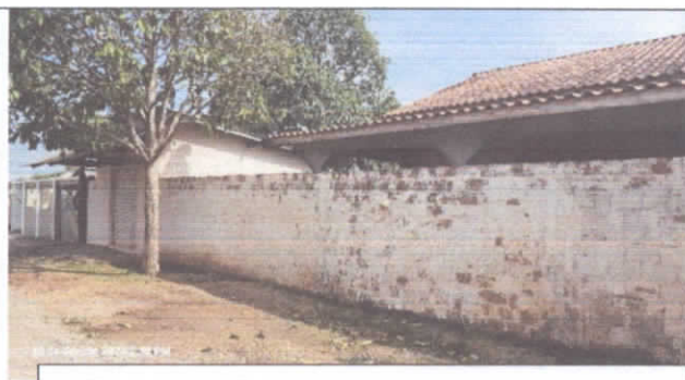
Fotos 3 – Fachada do ponto comercial
