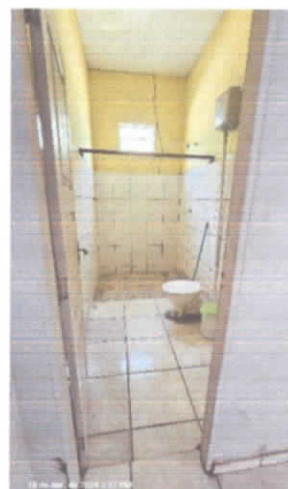
Fotos 11 – Banheiro Social
