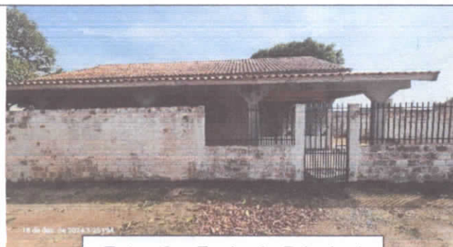
Fotos 2 – Fachada Principal
