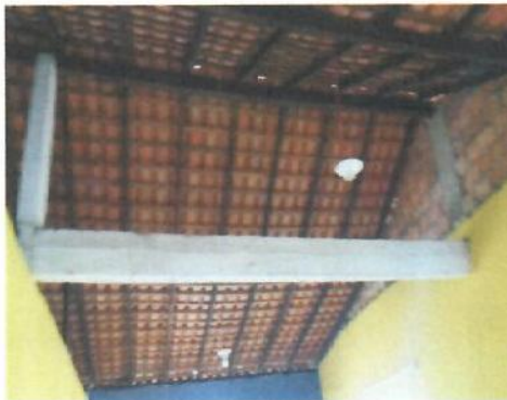
VISTA INTERNA DO TELHADO
