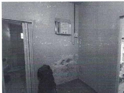
Quarto com parede úmida e descascando
