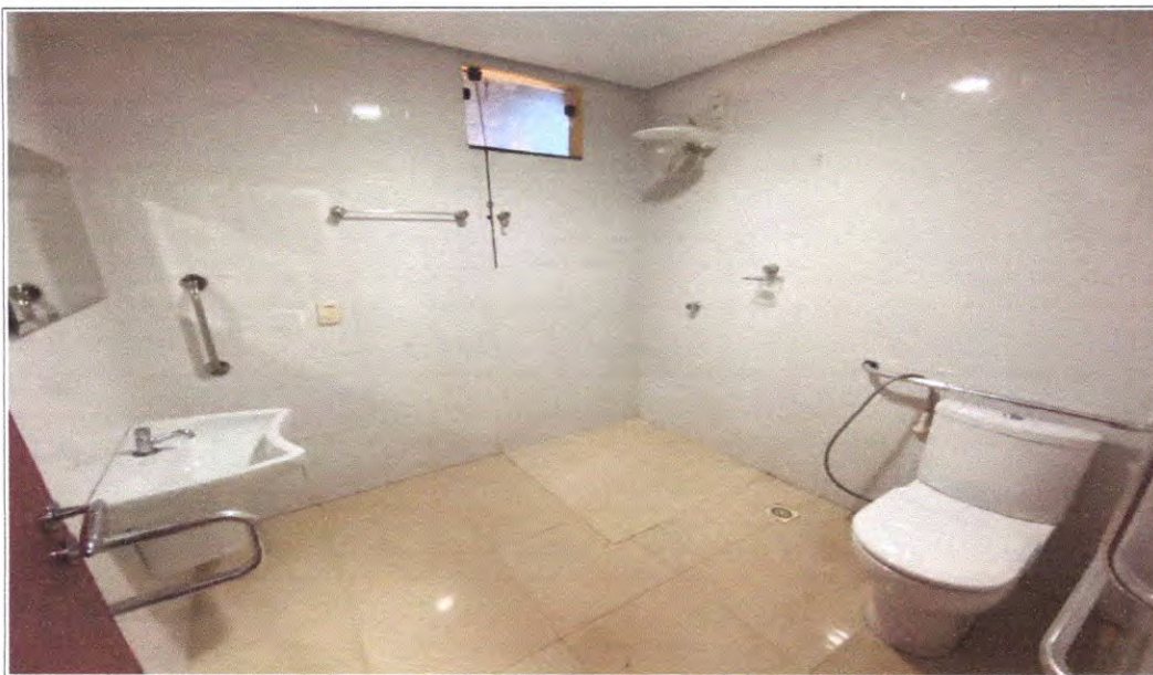
Foto 09: Banheiro PcD atendendo às normas de acessibilidade.
