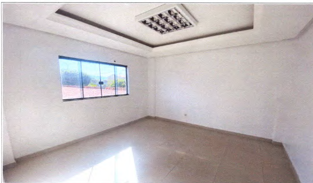
Foto 22: Sala 05 localizada no pavimento superior.
