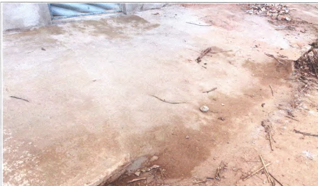
Foto 02: Rampa localizada na entrada principal atendendo às normas de acessibilidade.
