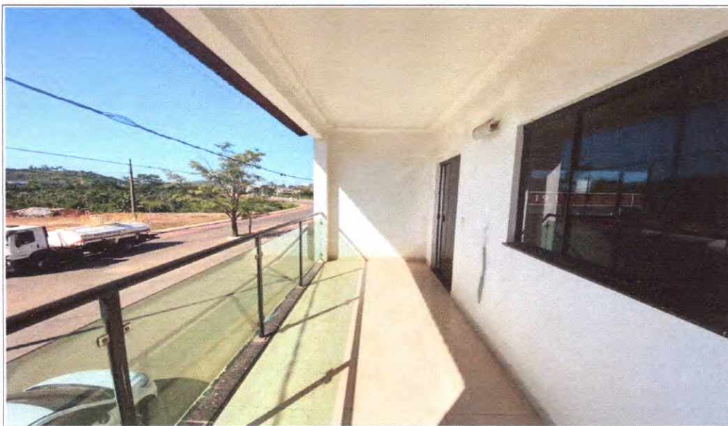
Foto 17: Varanda 01 localizada no pavimento superior.
