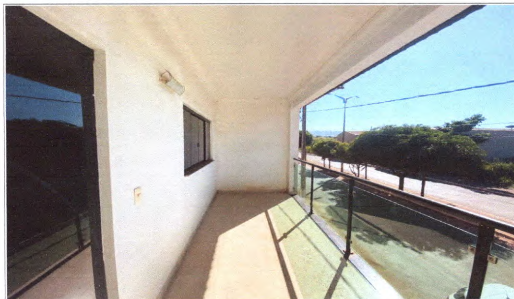
Foto 16: Varanda 01 localizada no pavimento superior.
