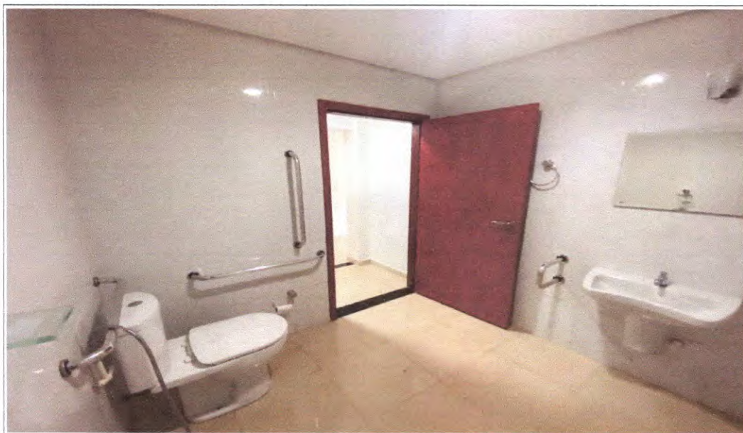
Foto 08: Banheiro PcD atendendo às normas de acessibilidade.
