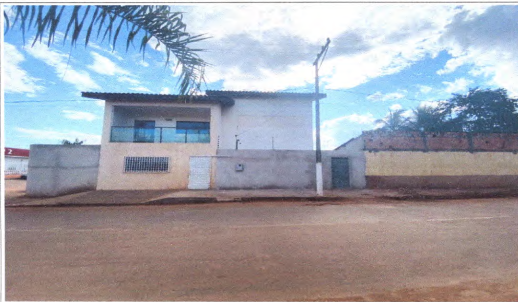
Foto 01: Fachada da edificação.
