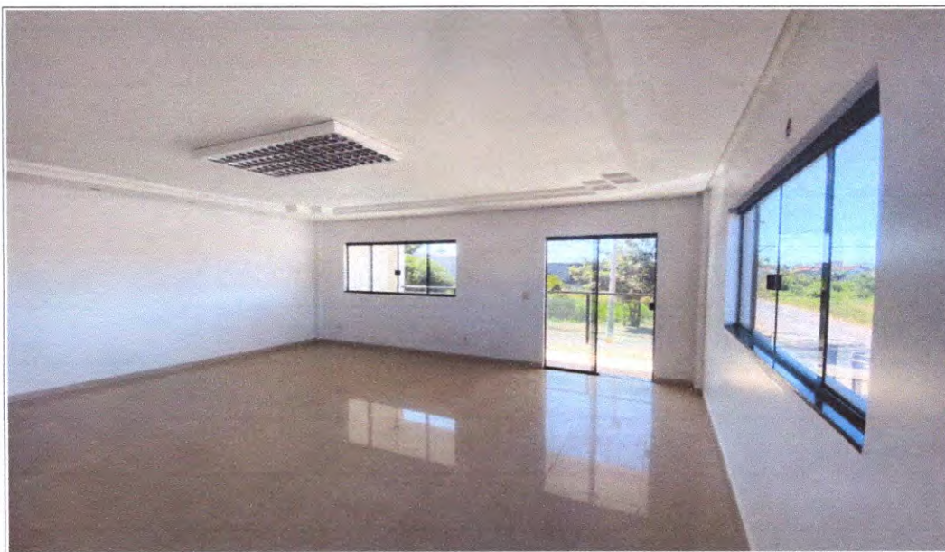
Foto 15: Sala 03 localizada no pavimento superior.
