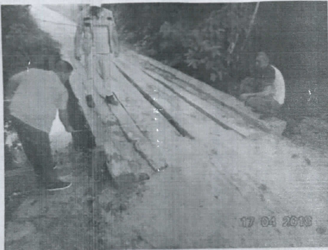
Ponte Pedra Branca GPS (S1°47'27.1" W55°11'57.5") – Foto 21
