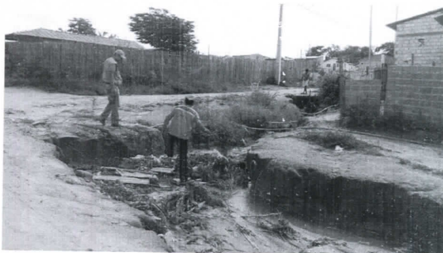
Travessa Isaac Hamoy com Rua 13 de Maio – Foto 06
