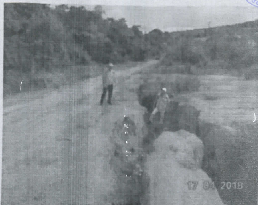
Ladeira Vicinal Comunidade Curumu GPS (51°49'03.7"W 55°36'46.2") Foto 17
