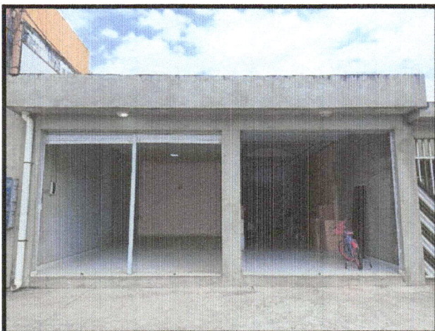
Foto 01: Vista principal do prédio.
