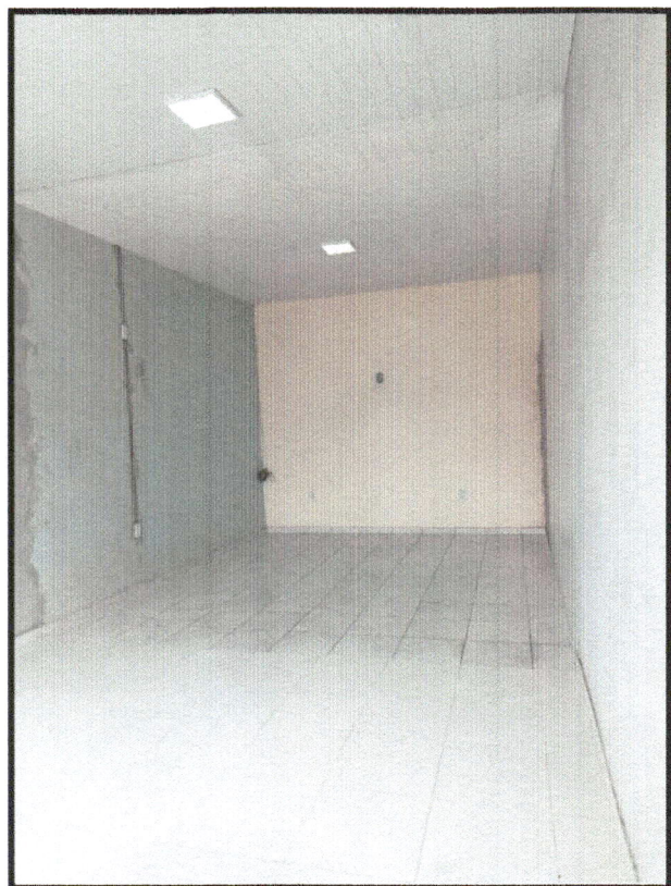
Foto 03: Vista da sala 01.
