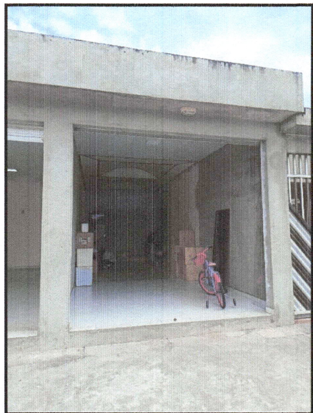
Foto 04: Vista da sala 02.
