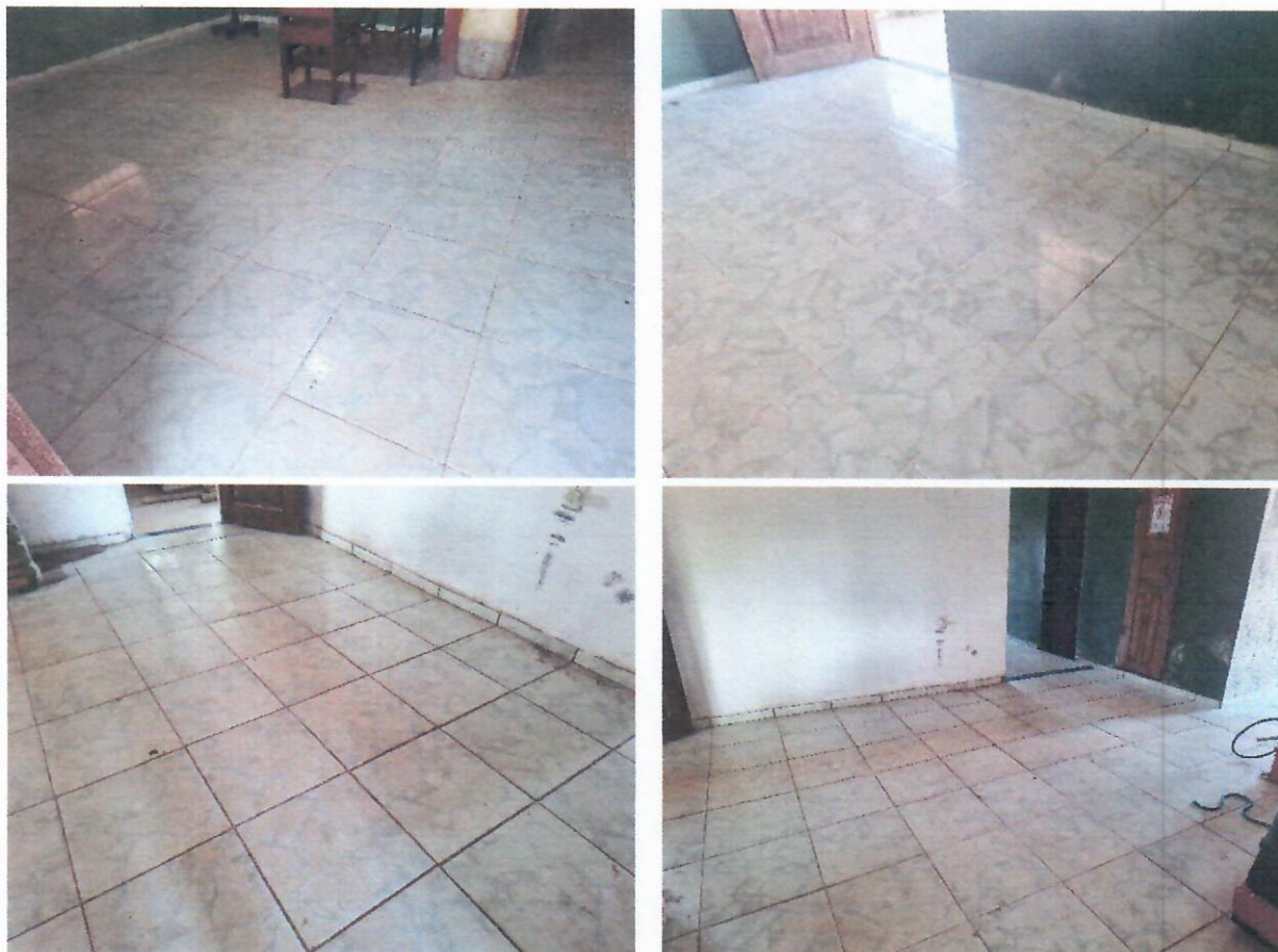
Fotos 13, 14, 15 e 16 – Piso do Imóvel
