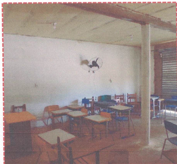
Foto 01: Sala de Aula
