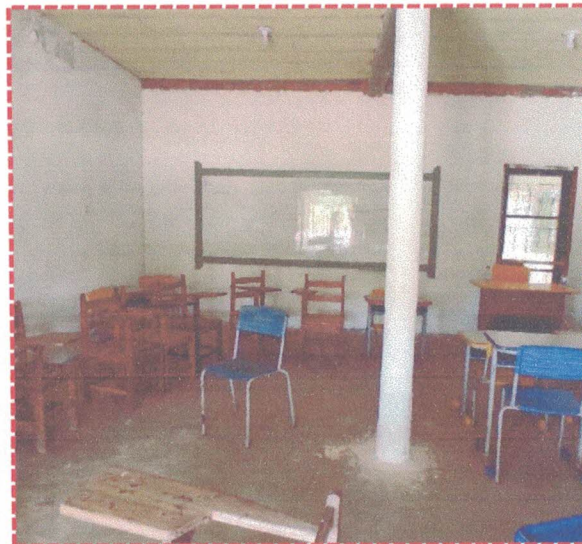
Foto 02: Sala de Aula
