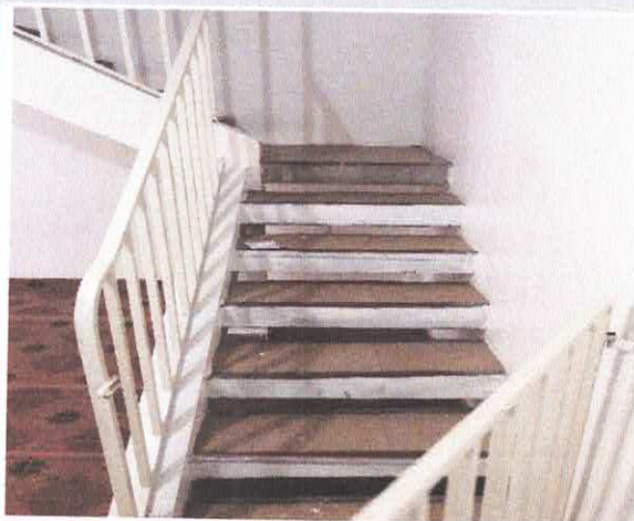
Foto 20 – Escada (acesso Pav. Superior)
