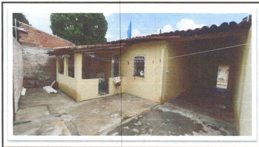
Foto 04: Vista dos fundos com área de serviço e garagem.
