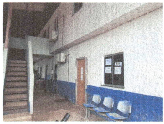
FOTO 03 – Escada para o superior e circulação para a copa, 03 salas de depósitos e banheiro.
