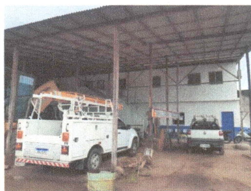
FOTO 02 – Estacionamento e prédio principal.
