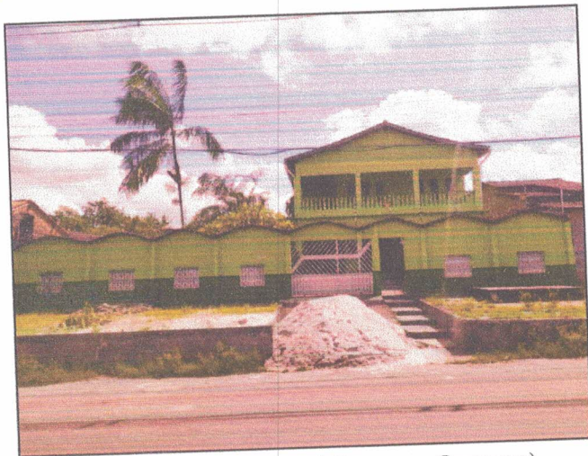
Foto 01: Fachada Principal (Rod. Bragança - Capanema). Fonte: SEPLAN
