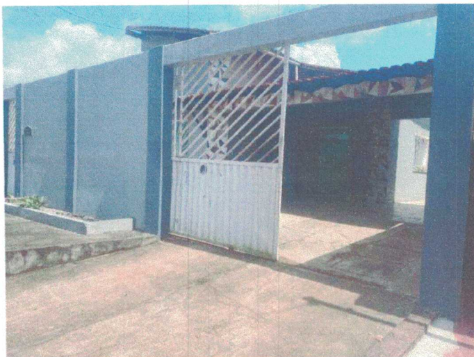
Portão de acesso.
