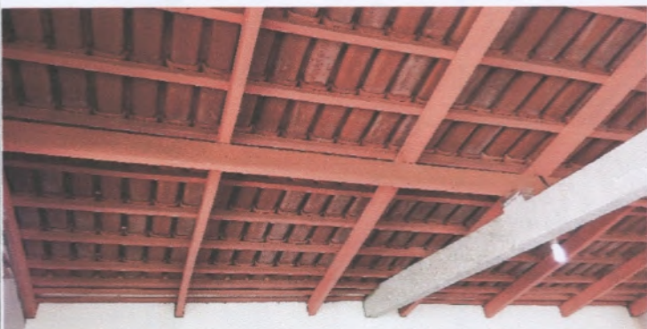
Estrutura Telhado Área Externa
