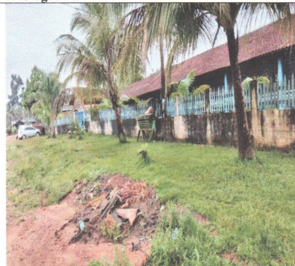
1 foto: alvenaria frontal a ser demolida
