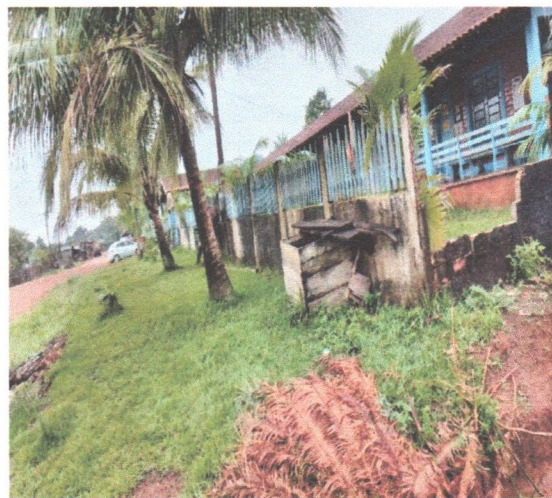
2 foto: alvenaria frontal a ser demolida
