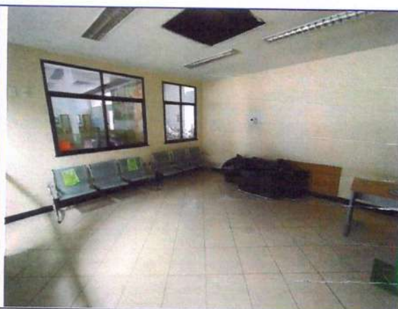
Foto 58: Sala de espera 03
