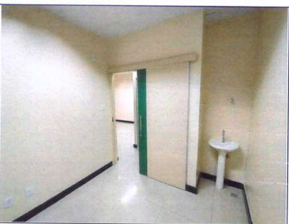
Foto 82: Anexo à sala 02
