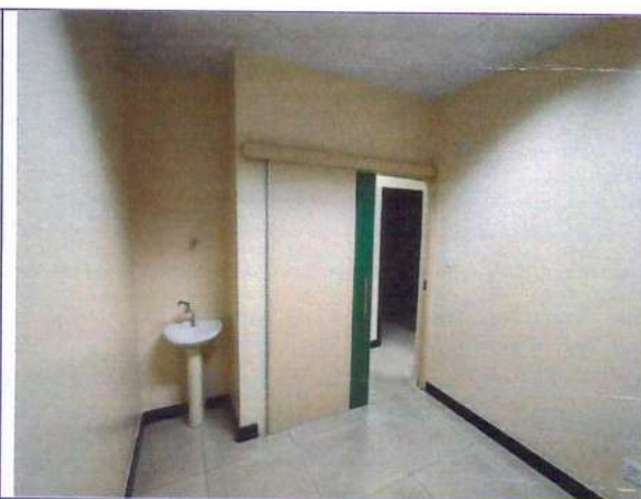
Foto 84: Anexo à sala 02
