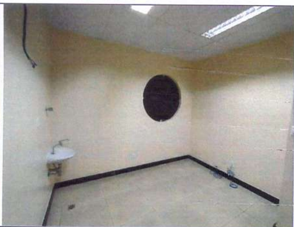
Foto 80: Anexo à sala 02
