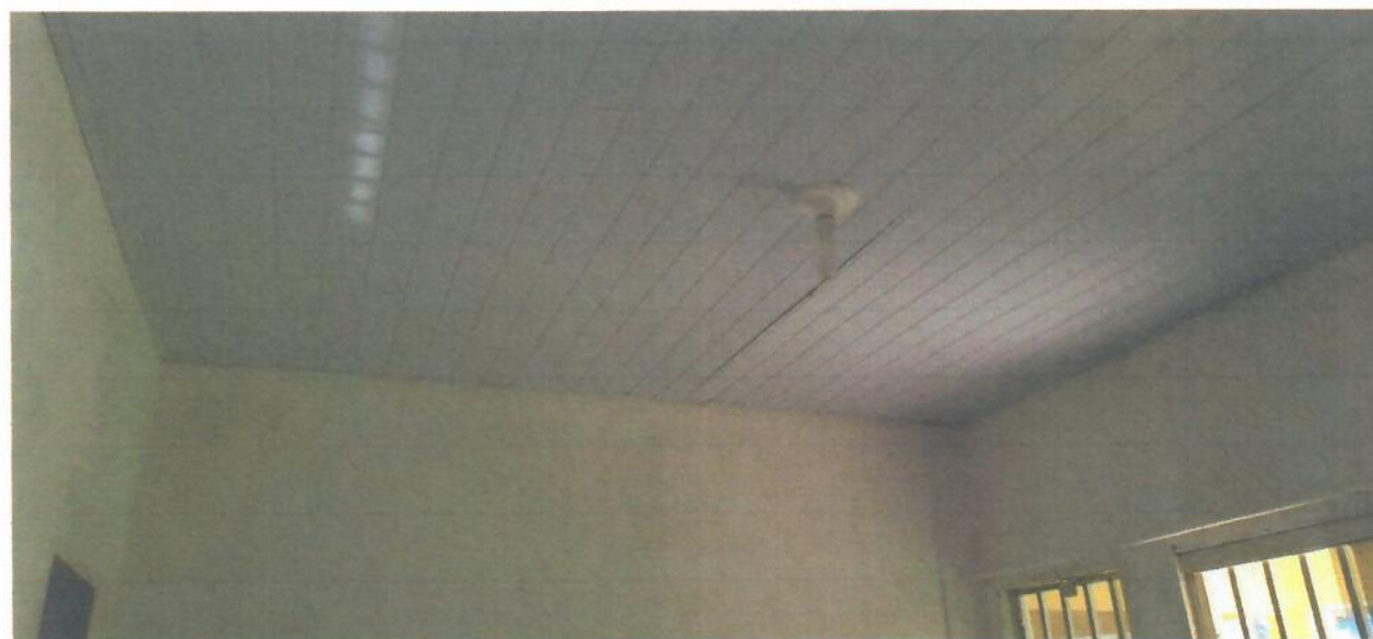
Foto 06 – Sala 02 – parede e forro
