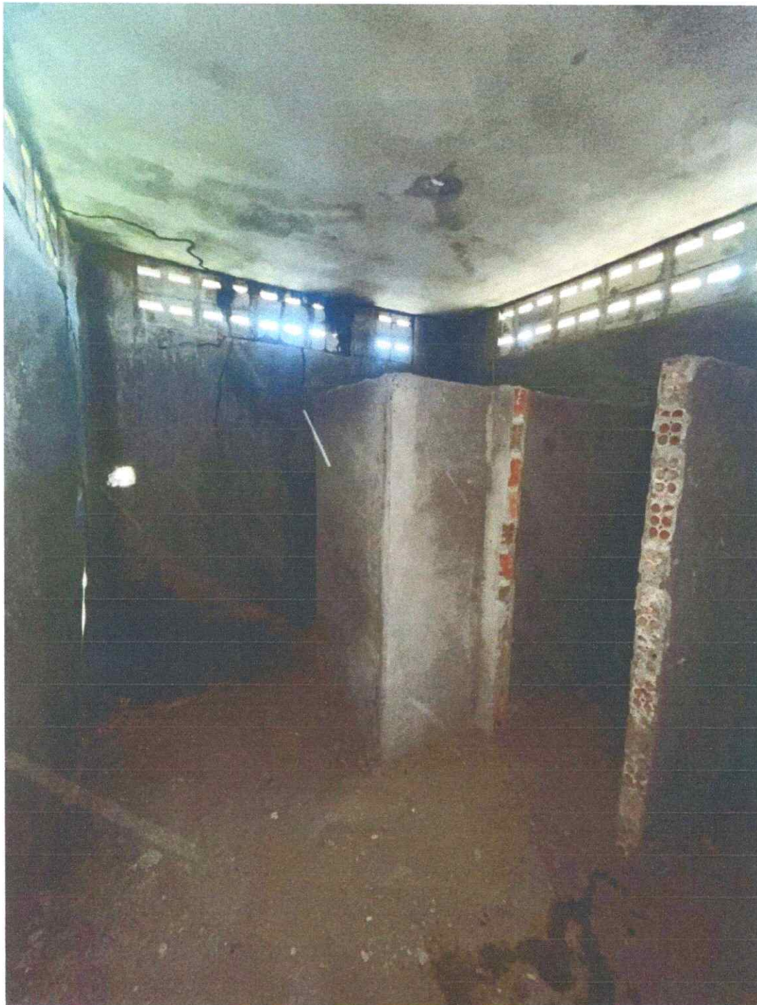
Foto 04- Interior dos Vestiários
