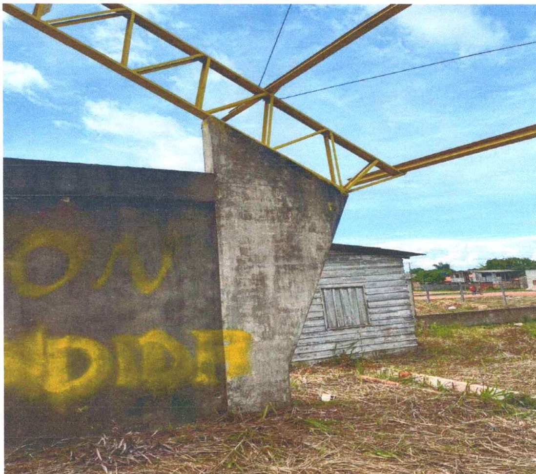
Foto 01: estrutura de concreto armado
