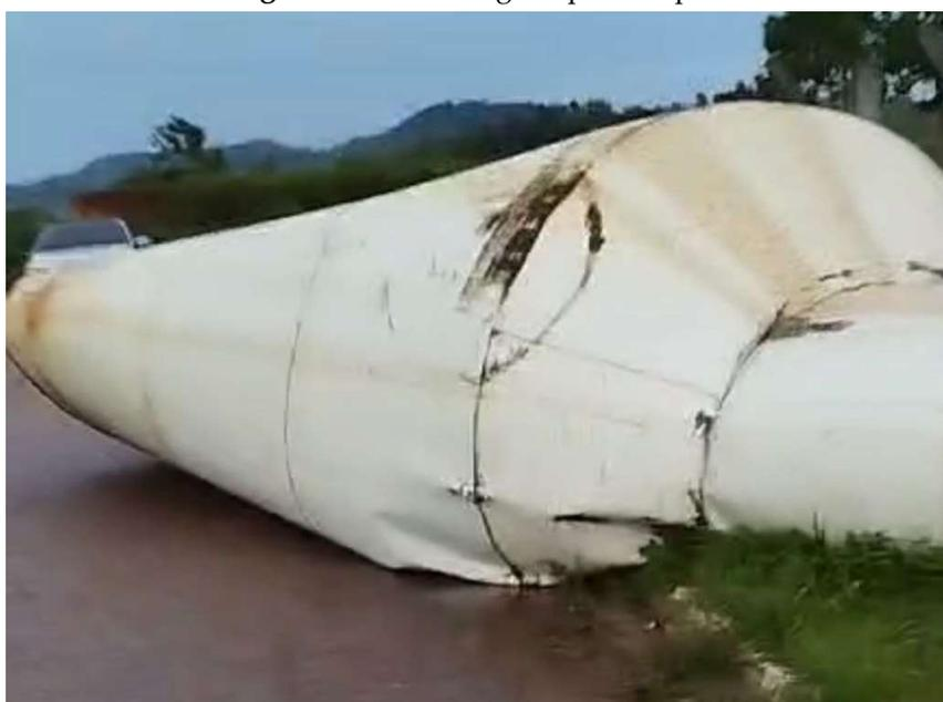
Figura 2 – Caixa d'água após colapso.
