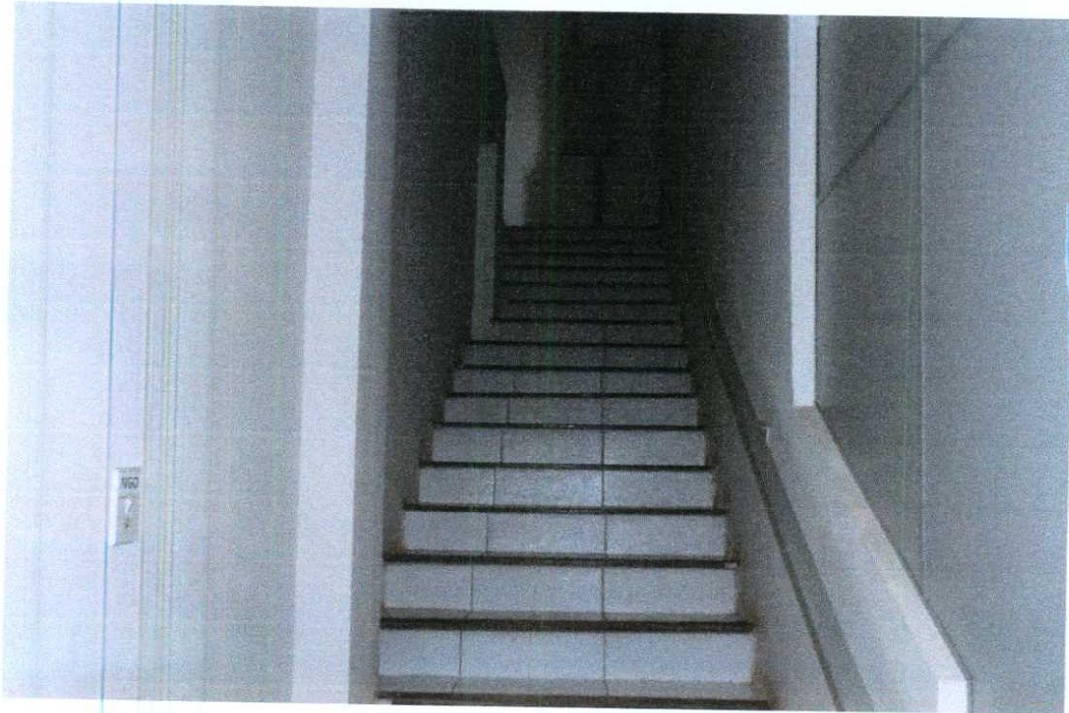
Foto 05 – Hall de escada.
