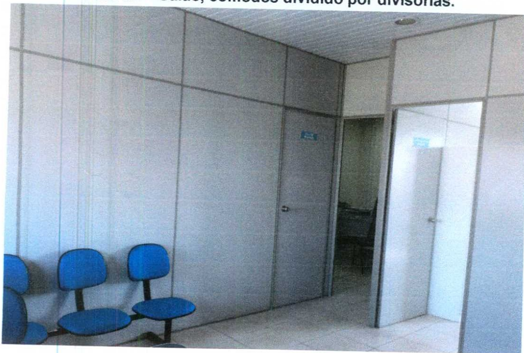
Foto 09 – Salão, cômodos dividido por divisórias.
