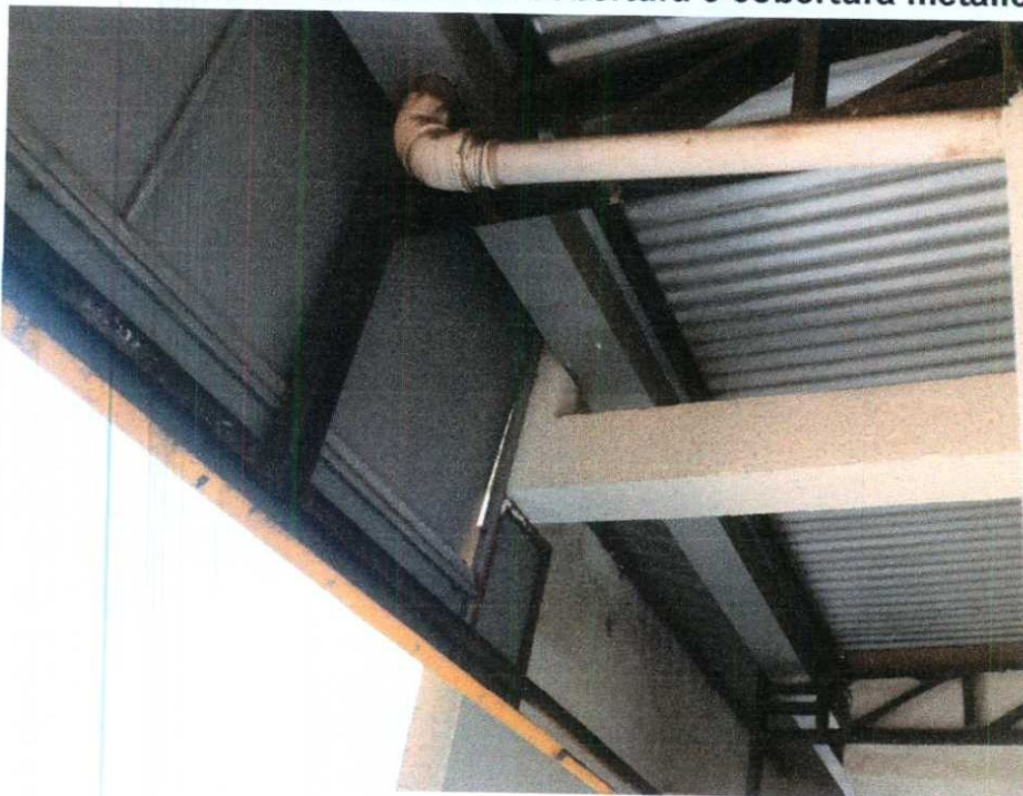
Foto 06 – Estrutura da cobertura e cobertura metálica.
