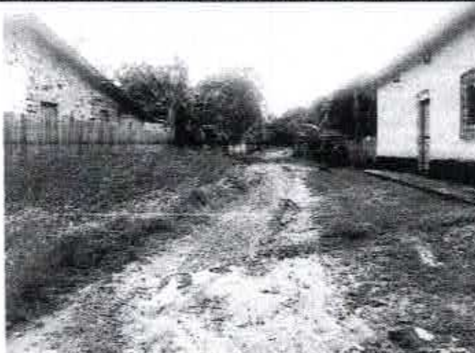
Travessa N.S. Nazare entre I – Rua Campos Sales F – Travessa São Lucas
