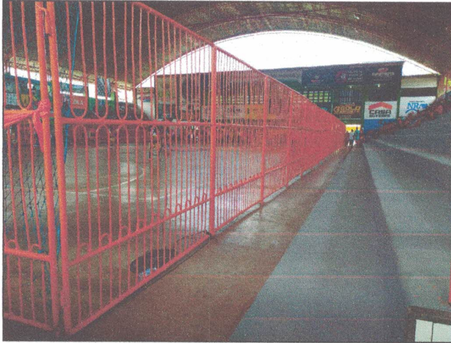
Foto 07: Alamedado em perfil metálico. Fonte: SEPLAN
