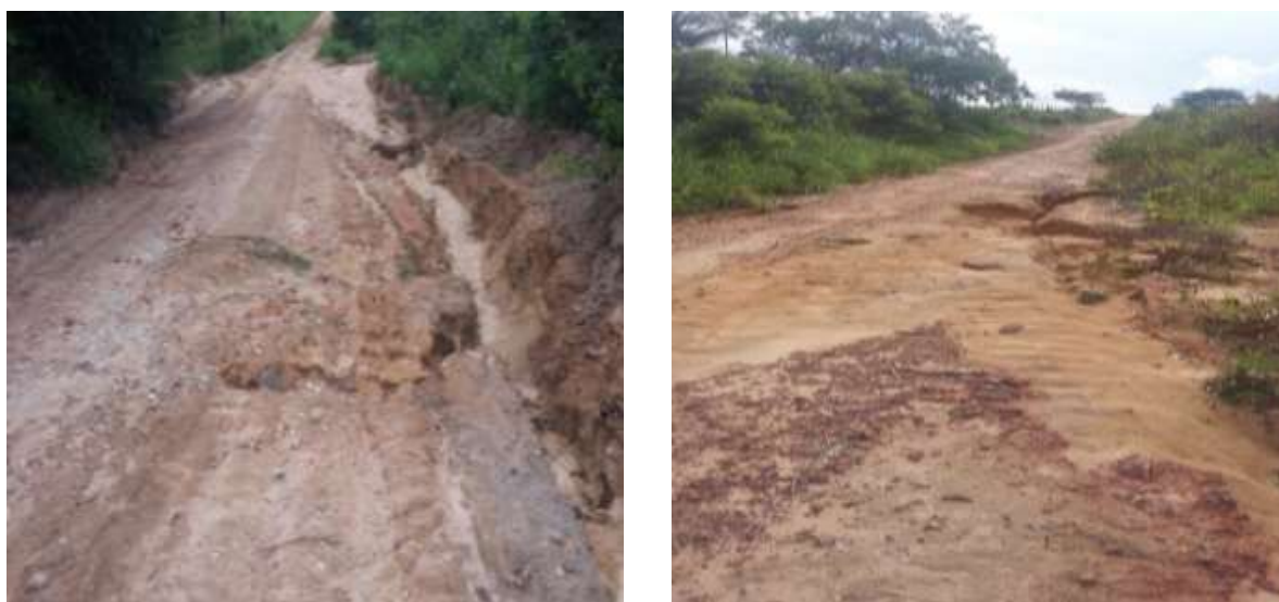
Fotos 19 e 20 - Erosão em estradas
