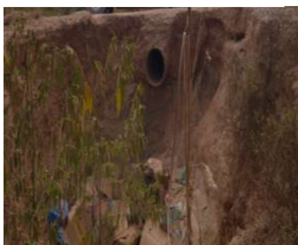
Fotos 23 e 24 - Leito da estrada sujeito a erosão
