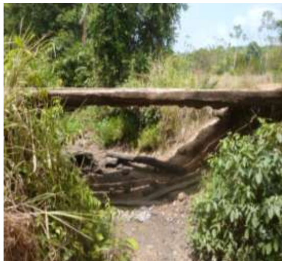
Foto 16- Apodrecimento nos componentes da mesa
