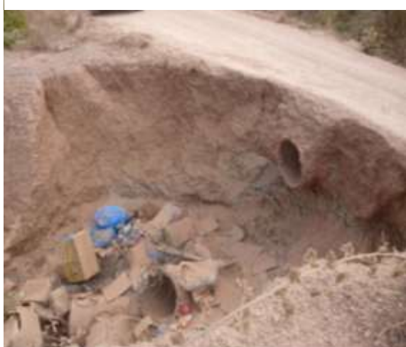
Fotos 23 e 24 - Leito da estrada sujeito a erosão
