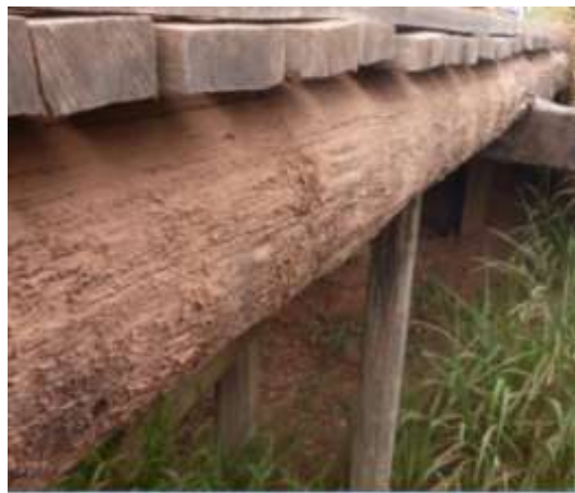
Foto 08 -Peças de madeira com fendilhamento
