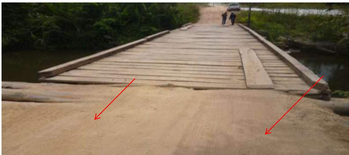
Foto 03-Cabeceira de ponte a aterrar
