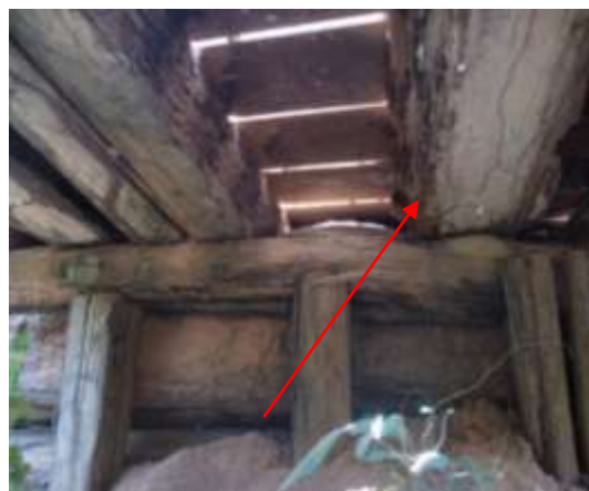
Fotos 05 e 06- Peças de madeira desprotegidas
