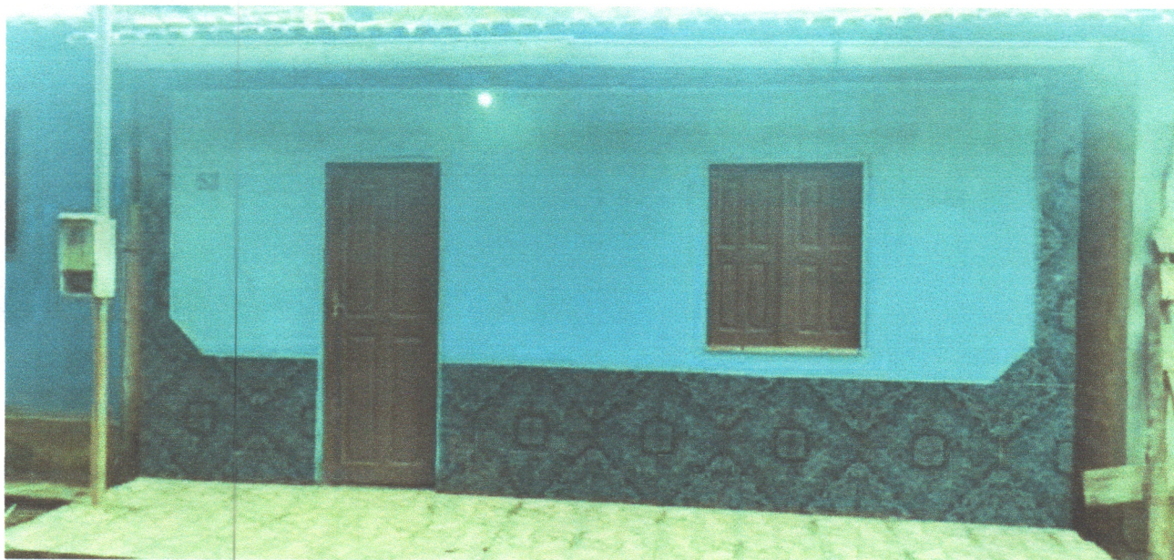
Figura 01: Vista frontal do imóvel
