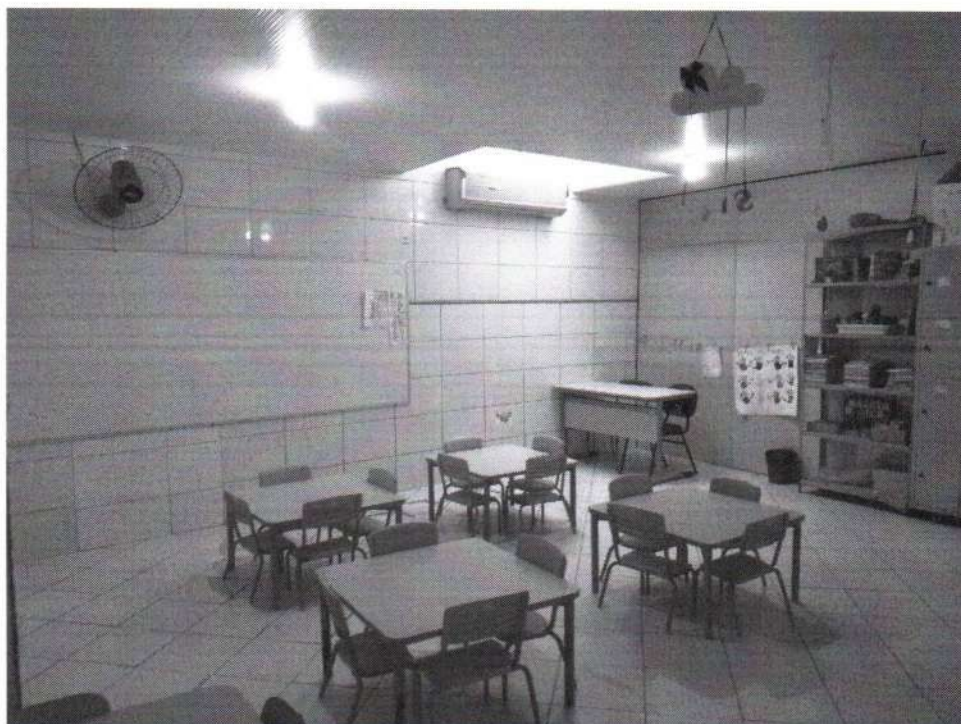
FOTO 05 - REVISÃO NOS APARELHOS DE AR CONDICIONADO – SPLIT
