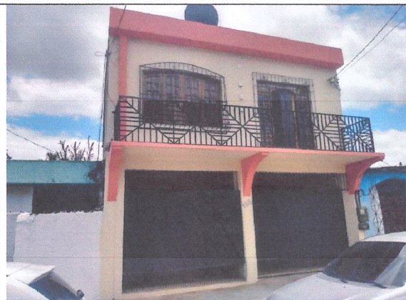
Foto 01: Fachada do imóvel.
