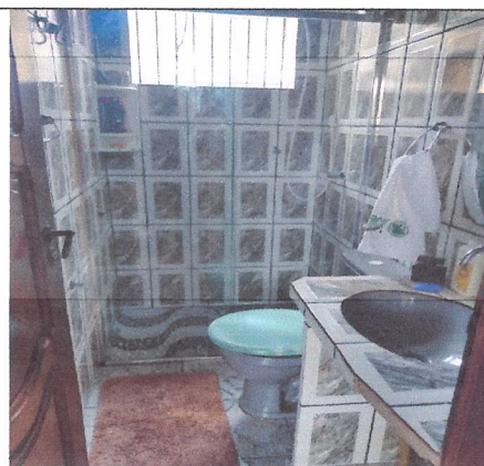
Foto 18: Banheiro social 2 (pav. superior).
