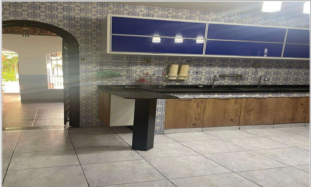
Figura 09 – Instalação de divisória para isolamento da cozinha (semec)
