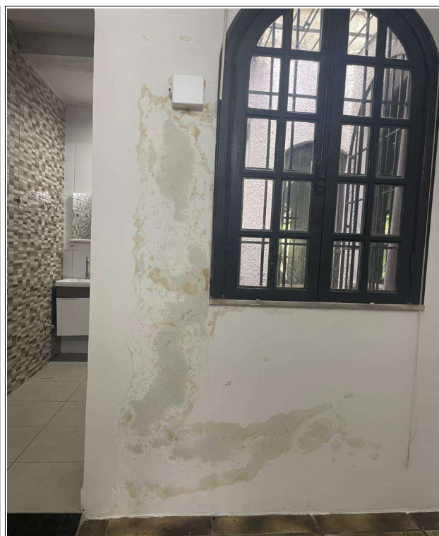
Figura 04 – Tratamento das infiltrações (proprietária)
