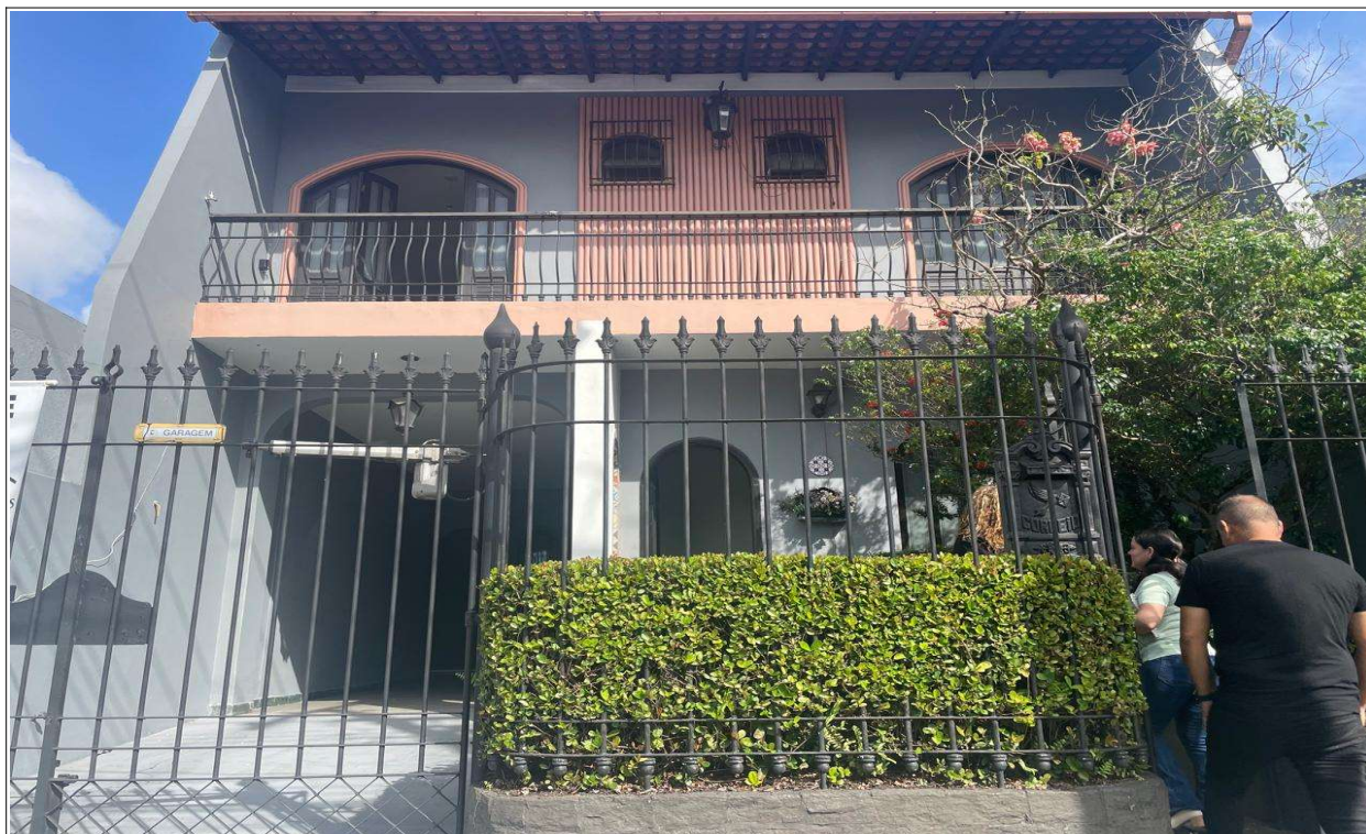
Figura 01 – Fachada de imóvel
