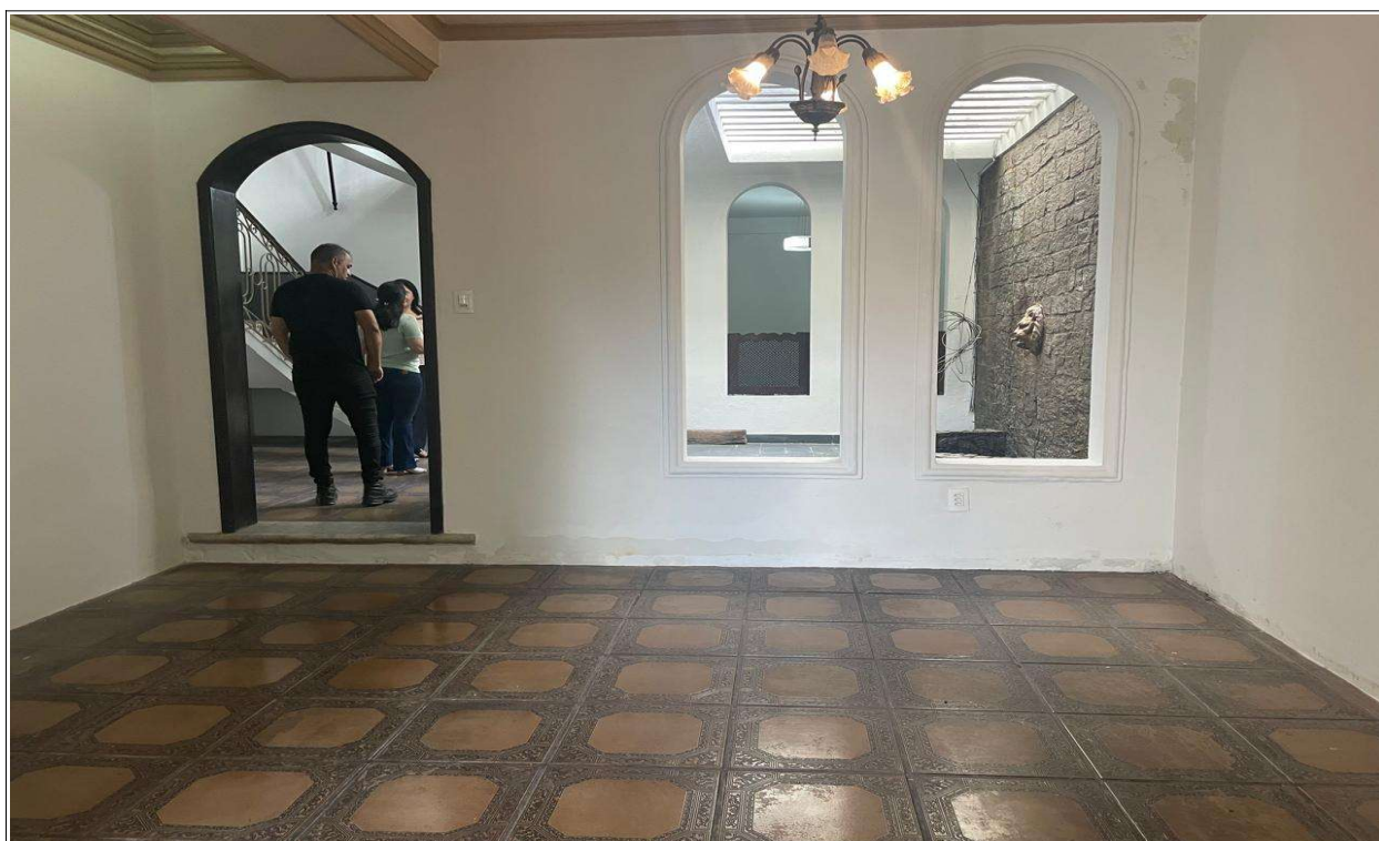
Figura 06 – Instalação de porta e fechamento das janelas para criação de uma sala de aula (semec)
