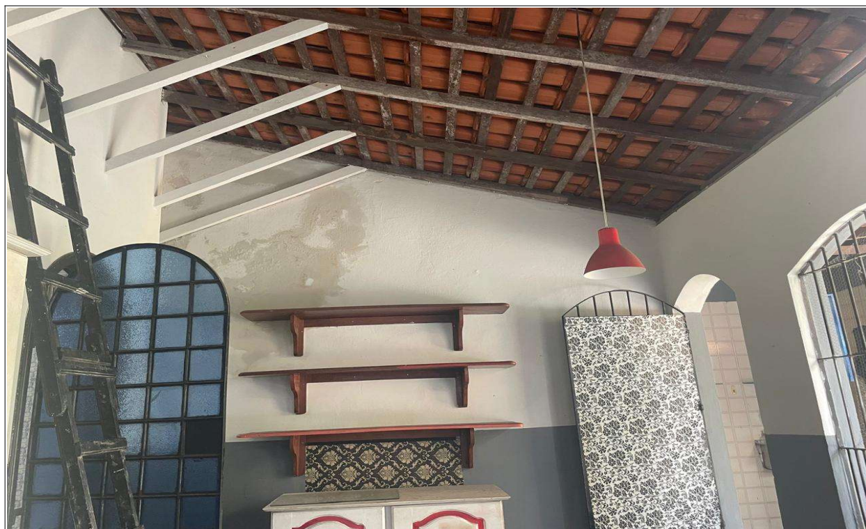
Figura 02 – Instalação de forro em PVC (proprietária)
