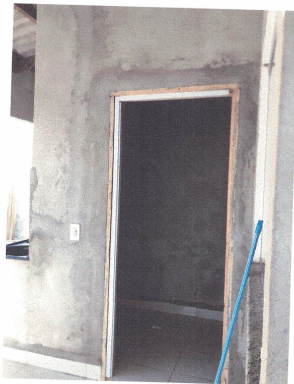
Imagem 60: vão de passagem do depósito (sem porta e guarnições).
