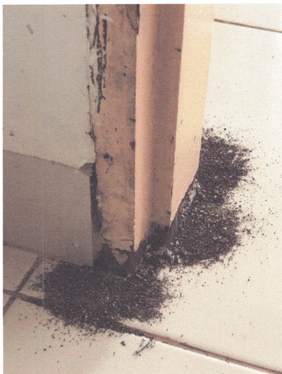
Imagens 20 e 21: interior do quarto - base do batente da porta e fechadura da porta com avarias.
