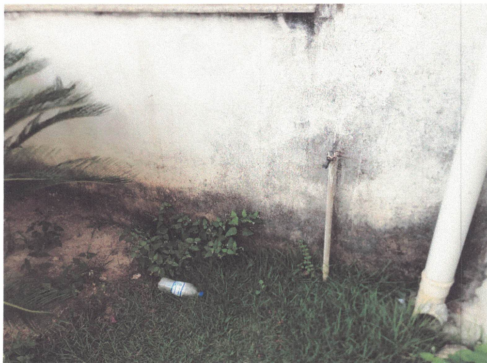
Imagem 04: ponto de água externo à edificação.
