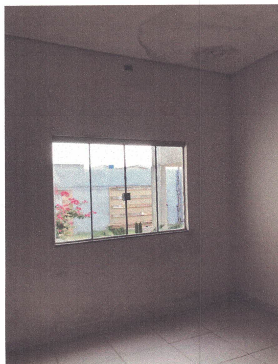
Imagens 14 e 15: vista interna do quarto (forro e parede com infiltrações).
