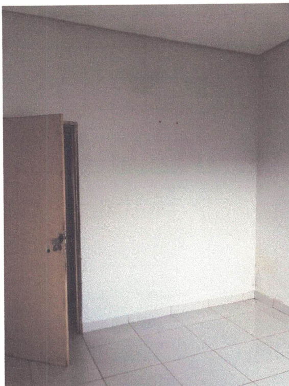
Imagens 18 e 19: interior do quarto (porta sem alisar e fechadura avariada).
