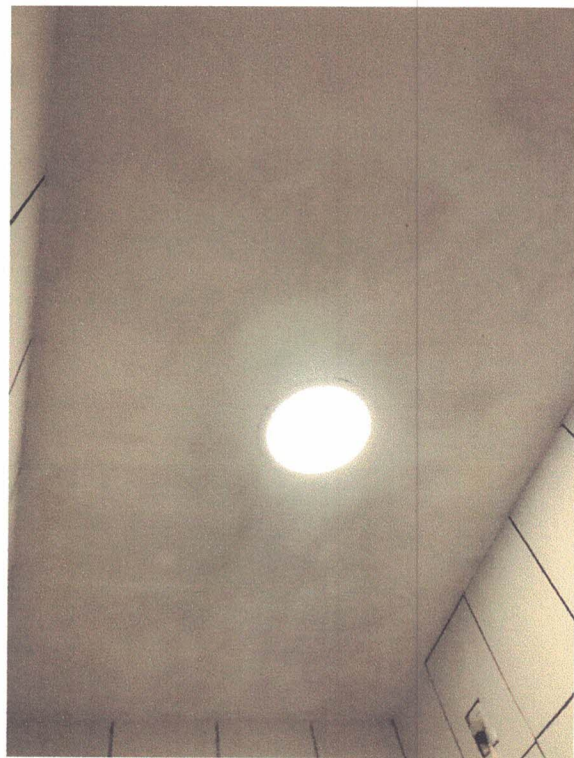
Imagens 28 e 29: interior do banheiro social – vão de ventilação (janela sem vedação) e forro com infiltrações.
