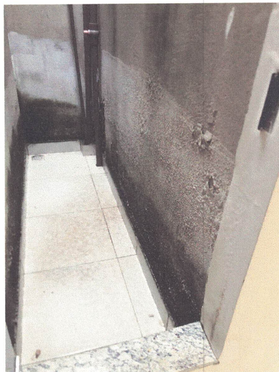
Imagens 38 e 39: Fosso de ventilação da suíte (muita infiltração).
