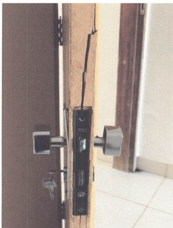
Imagens 33 e 34: fechadura da porta (avaria na madeira da porta) e entrada principal da suíte.
