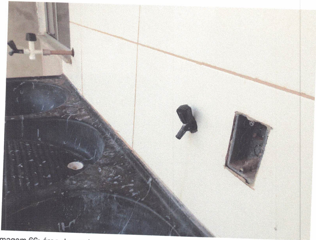
Imagem 66: área de serviço – torneira mal instalada (afundada na parede) e caixa para tomada sem espelho (vedação).
