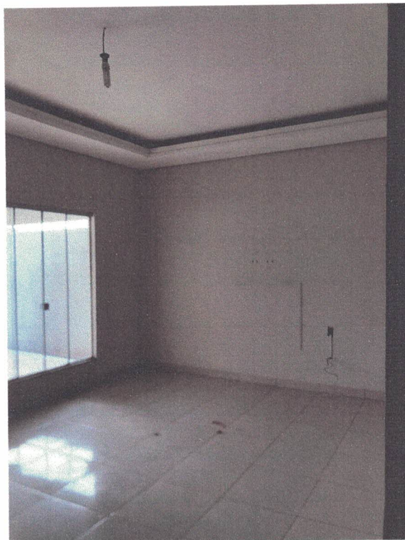
Imagem 13: vista interna da sala.
