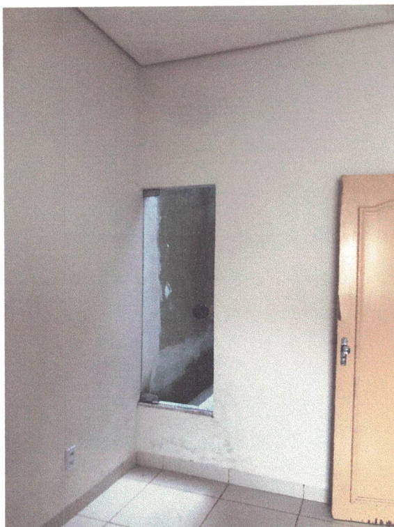
Imagens 38 e 39: Fosso de ventilação da suíte (muita infiltração).
