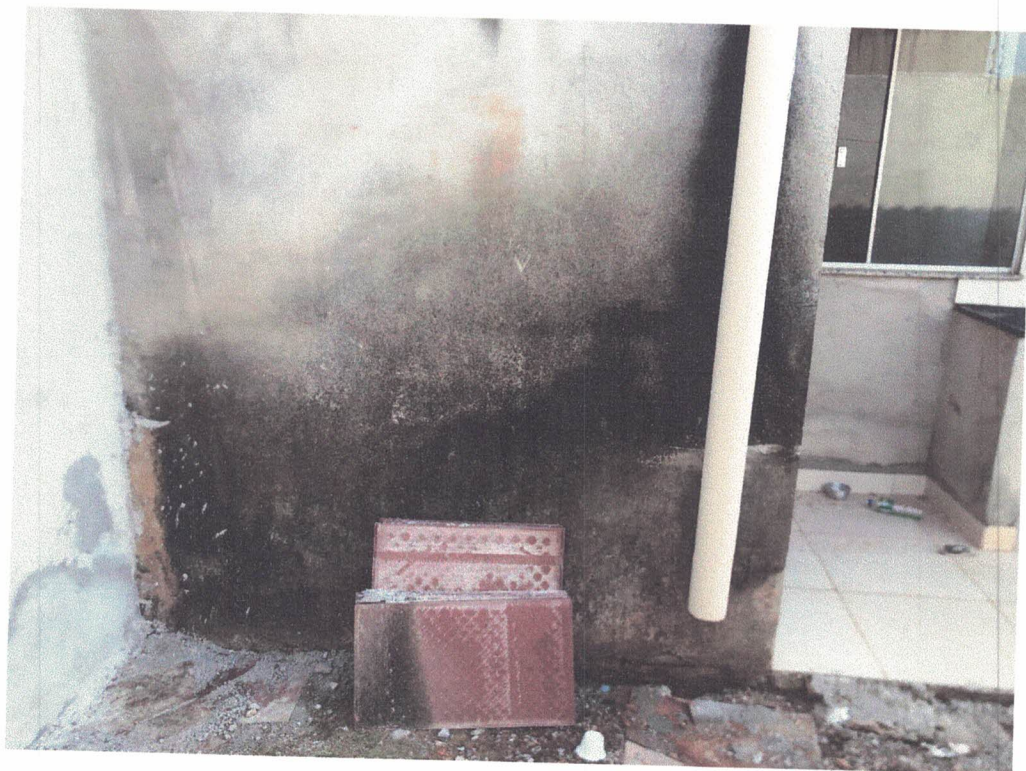
Imagem 58: cano para água pluvial vinda do telhado.
