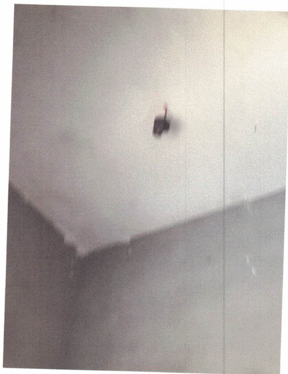
Imagens 62 e 63: parede sem pintura da varanda e bocal exposto para iluminação do depósito – sem lâmpada.
