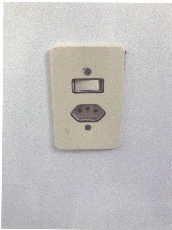
Imagem 46: banheiro da suíte - tomada e interruptor.
