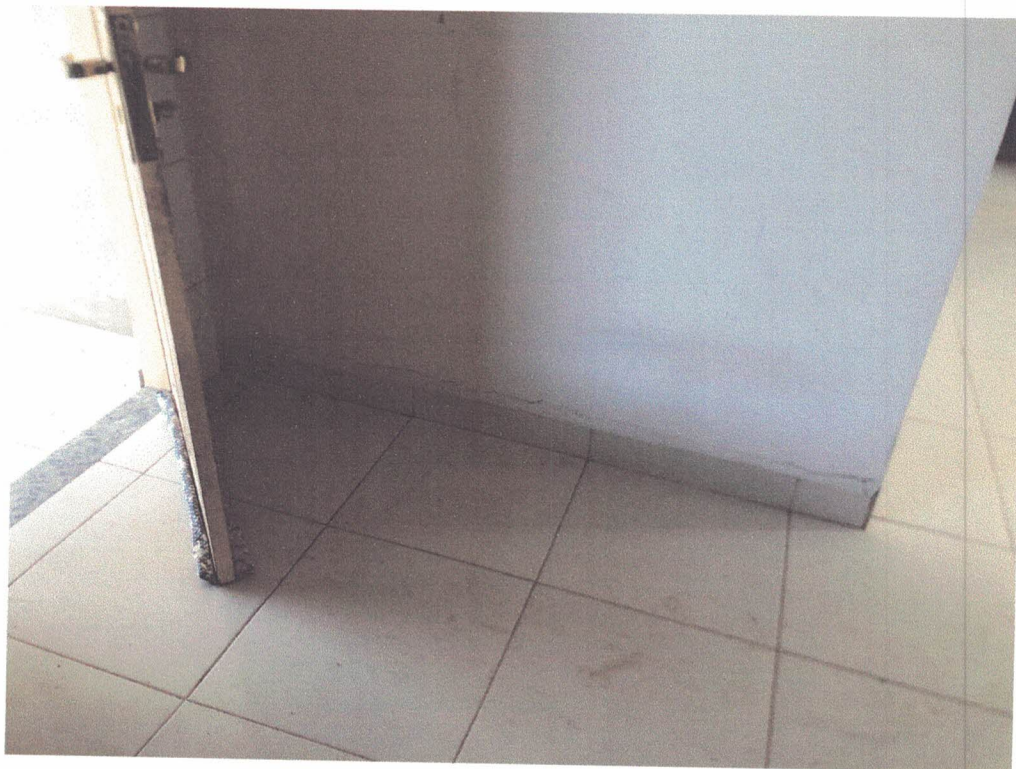
Imagem 53: piso e parede da cozinha.
