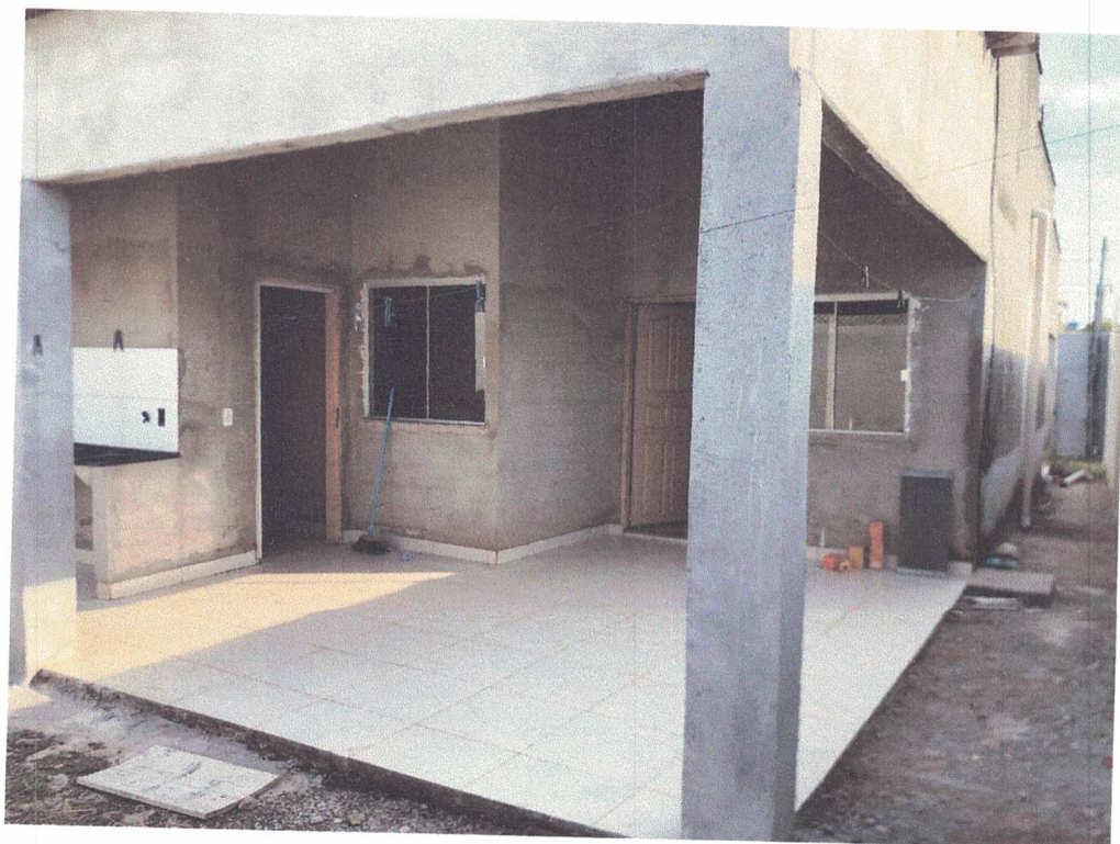
Imagem 56: varanda dos fundos e corredor lateral – sem pintura e portas sem alisares.
