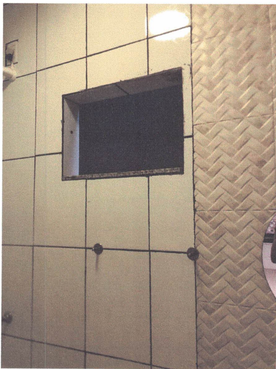
Imagens 28 e 29: interior do banheiro social – vão de ventilação (janela sem vedação) e forro com infiltrações.
