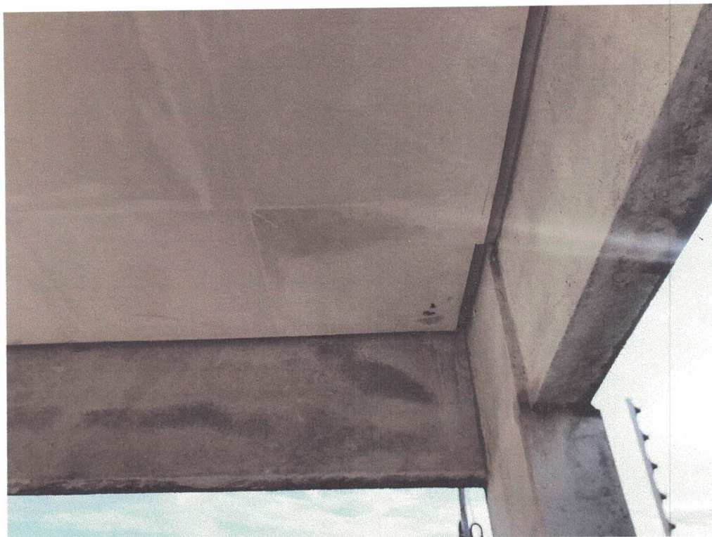
Imagem 07: estrutura e forro da garagem.
