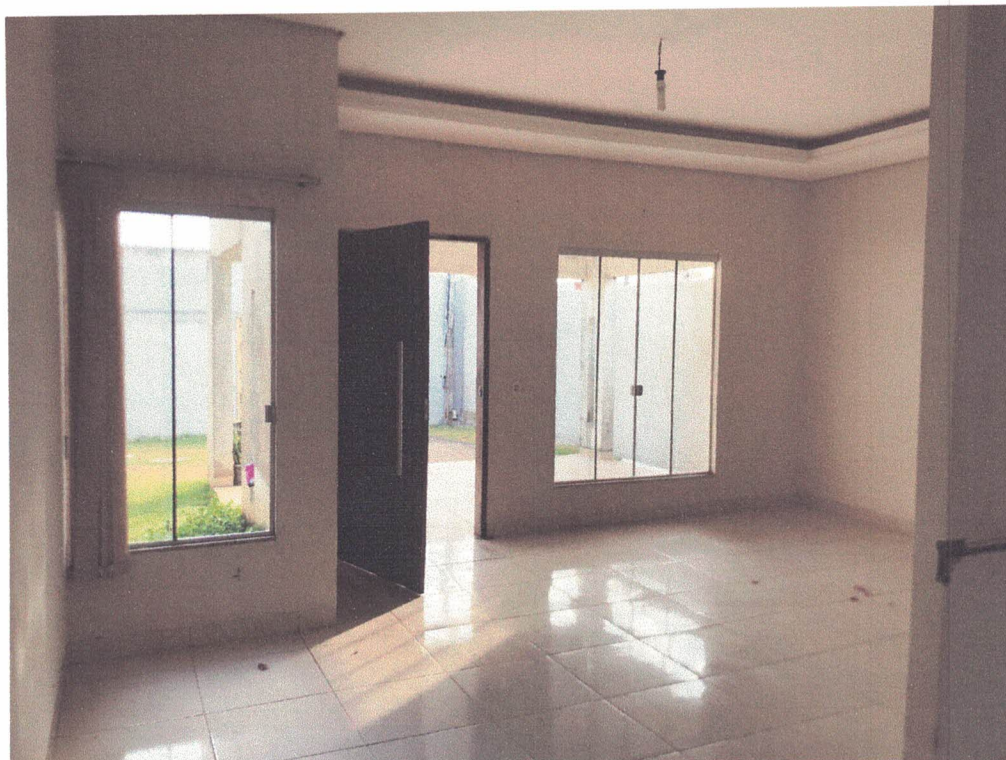
Imagem 11: vista interna da sala.
