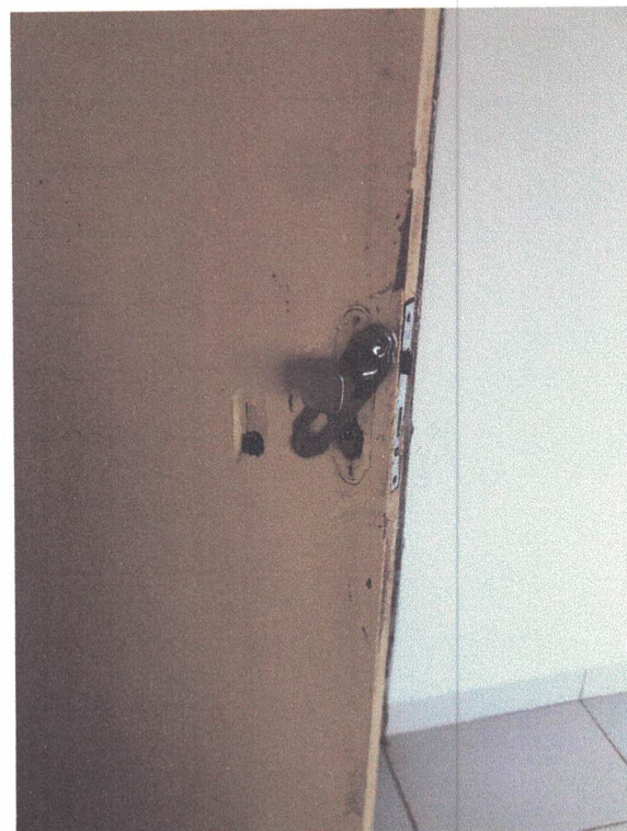
Imagens 18 e 19: interior do quarto (porta sem alisar e fechadura avariada).
