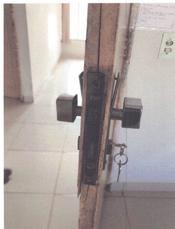
Imagens 20 e 21: interior do quarto - base do batente da porta e fechadura da porta com avarias.
