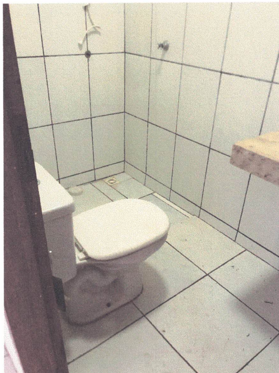
Imagens 32: interior do banheiro social - revestimento de parede e piso.
