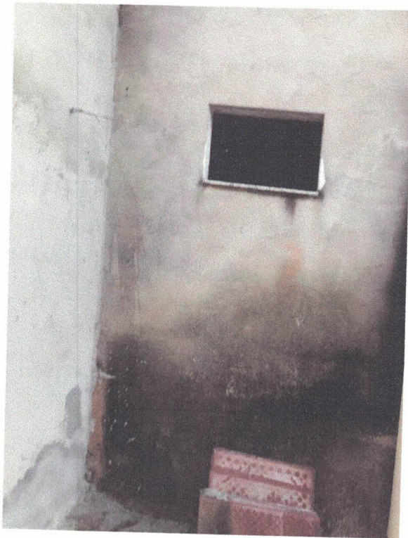
Imagem 59: vista externa da janela do banheiro da suíte (sem vedação) e
