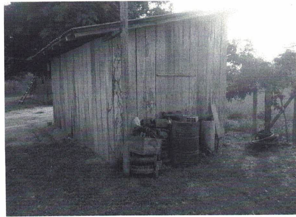
Figura 38: Fachada do depósito de materiais. Fonte: COSANPA (2015)
