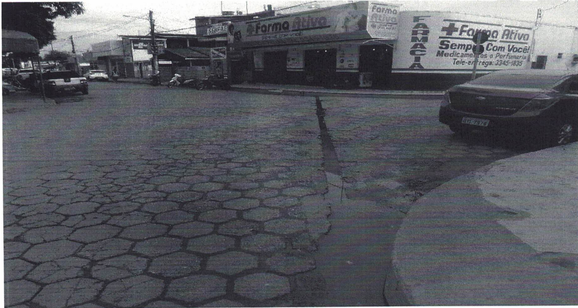
Figura 47: Lançamento de esgoto doméstico a céu aberto.
