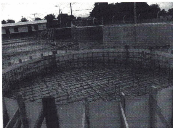
Figura 05: Armadura de aço em barra de barra \varnothing 1/4" e \varnothing 3/16" do FRD da ETA.
