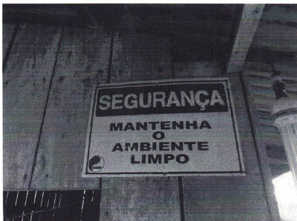
Figura 39: Detalhe do depósito de materiais. Fonte: COSANPA (2015).
