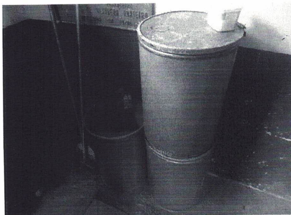
Figura 37: Estocagem das partilhas de cloro. Fonte: COSANPA (2015)
