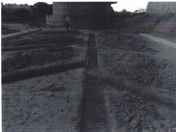
Figura 64: Base do Leito de Secagem.
