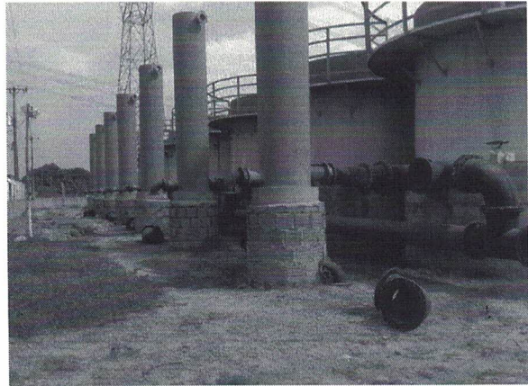
Figura 22: Montagem do barrilete da ETA.
