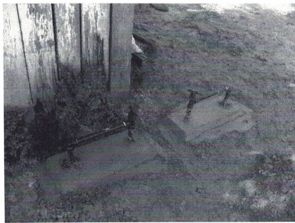
Figura 04: Assentamento de KIT cavalete com base de fixação.
