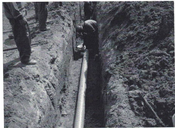
Figura 51: Assentamento da rede coletora de DN 150mm.
