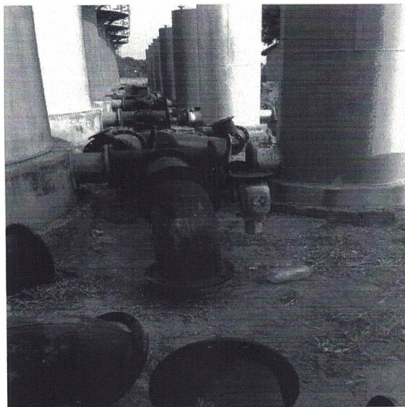
Figura 23: Montagem do barrilete da ETA.
