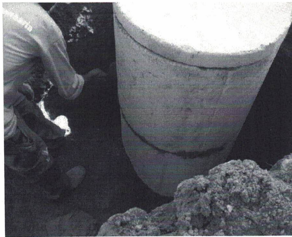
Figura 55: Execução de PV na rede de DN 150mm.
