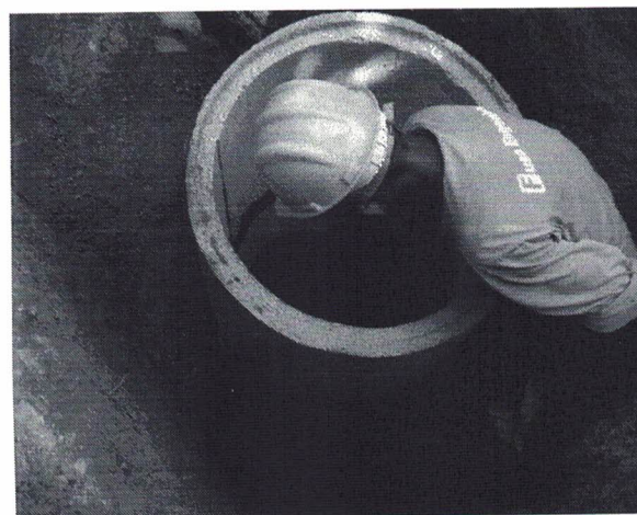
Figura 56: Execução de PV na rede de DN 150mm.
