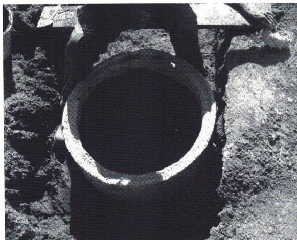
Figura 54: Execução de TL na rede de DN 150mm.
