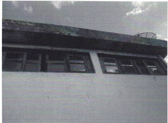
Figura 28: Vista lateral da EEAB. Fonte: COSANPA (2015).
