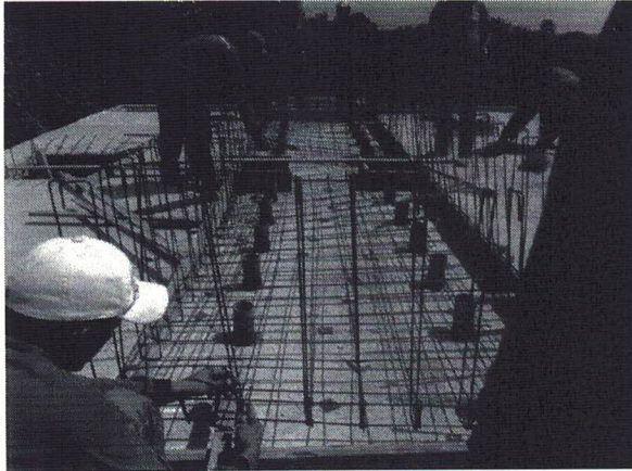
Figura 70: Drenagem de gases do Reator Anaeróbio.
