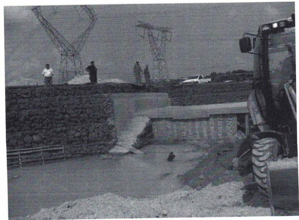
Figura 12: Proteção da barragem em gabião da Captação de Água.
