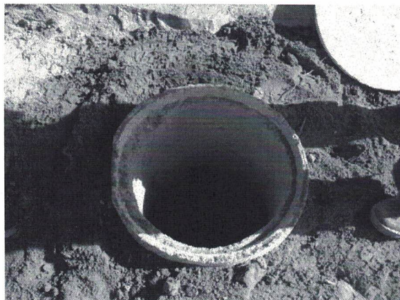
Figura 53: Execução de CL de CA DN 400mm.
