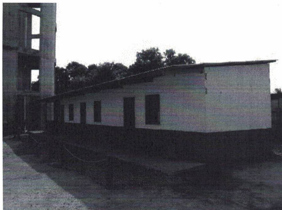
Figura 02: Barracão de obra.
