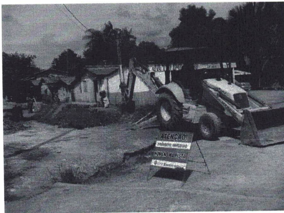
Figura 50: Escavação de vala para a rede coletora DN 150mm.
