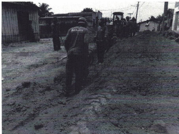
Figura 52: Compactação da vala que foi assentada a rede coletora DN 150mm.
