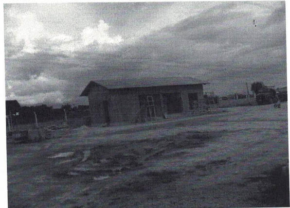
Figura 10: Casa de química da ETA.
