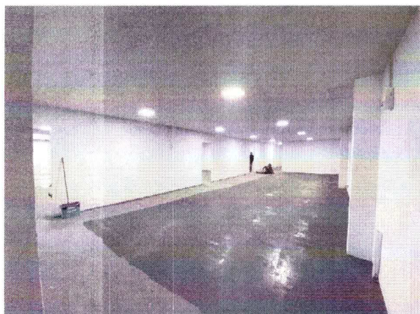
ÁREA INTERNA DO GALPÃO
