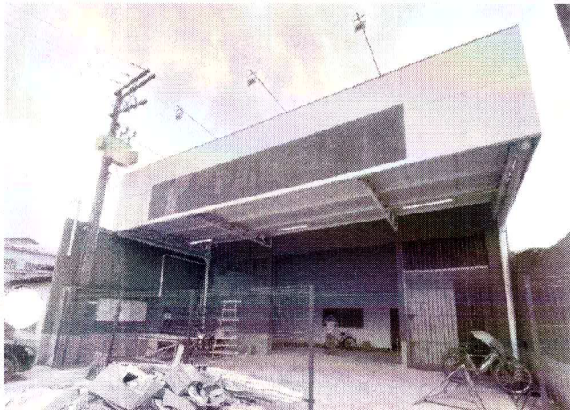
FRENTE DO GALPÃO
