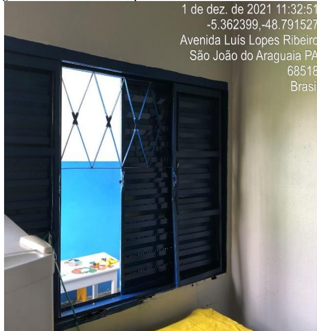
Figura 16. Creche Municipal Merivaldo Paiva
