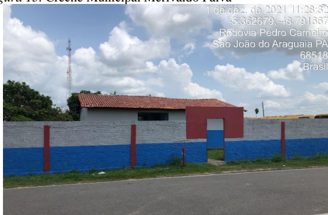
Figura 13. Creche Municipal Merivaldo Paiva
