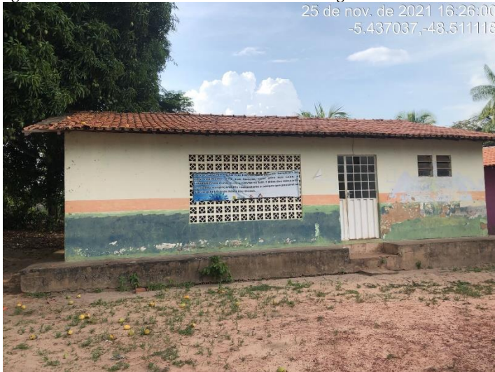
Figura 107. UBS Vila Ponta de Pedra do Araguaia
