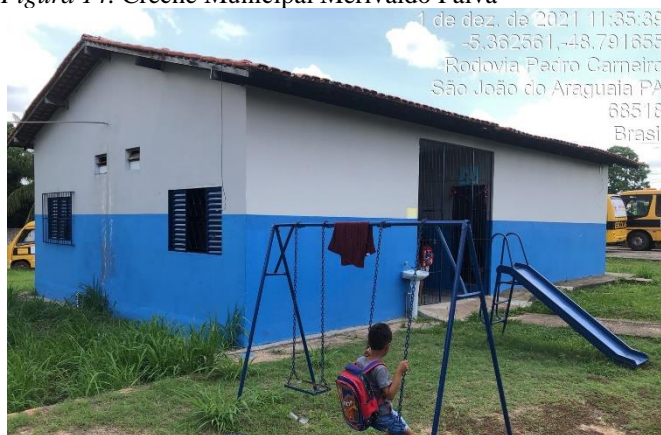
Figura 14. Creche Municipal Merivaldo Paiva
