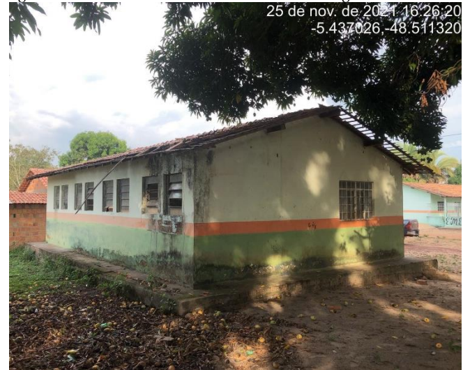
Figura 108. UBS Vila Ponta de Pedra do Araguaia
