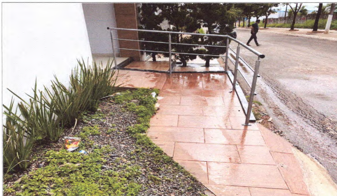
Foto 02: Rampa localizada na entrada principal atendendo as normas de acessibilidade.
