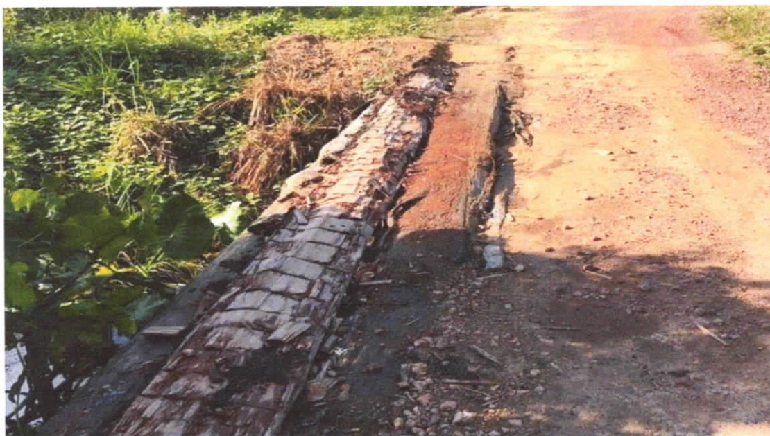
Foto 06 - Revitalização da ponte
