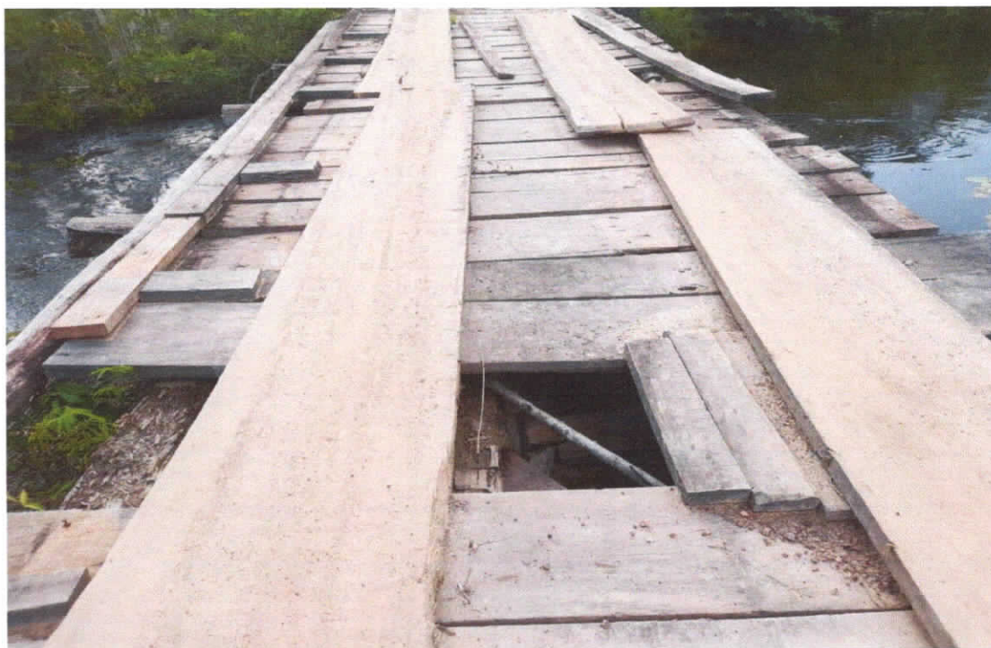
Foto 07 - Construção de ponte com cravação de estacas
