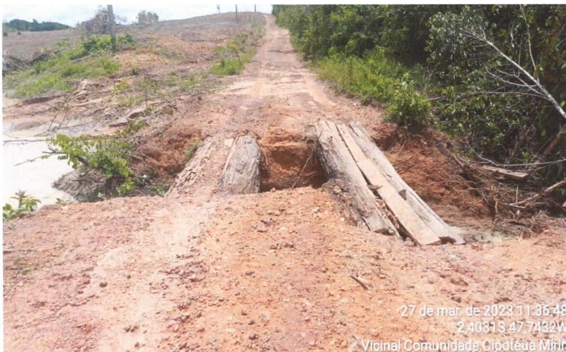
Foto 04 - Corrego na Vicinal Cipoteua Mirim (3) - Tubulação Tb-100
