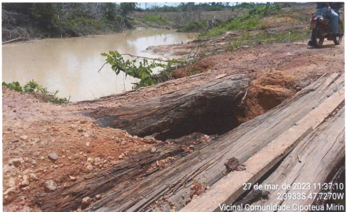
Foto 03 - Corrego na Vicinal Cipoteua Mirim - Tubulação Tb-120
