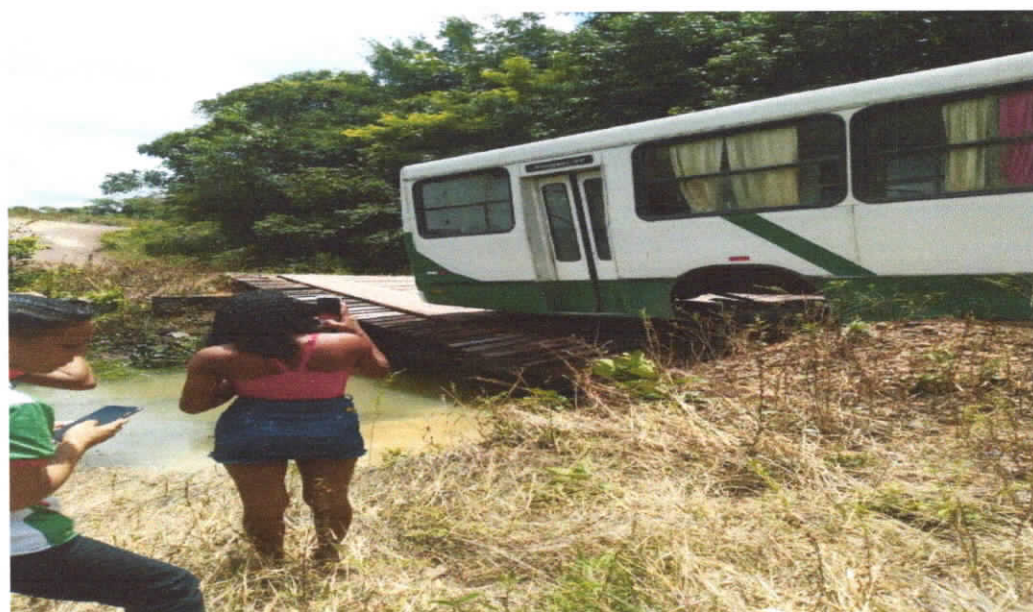
Foto 08 - Construção de ponte com cravação de estacas
