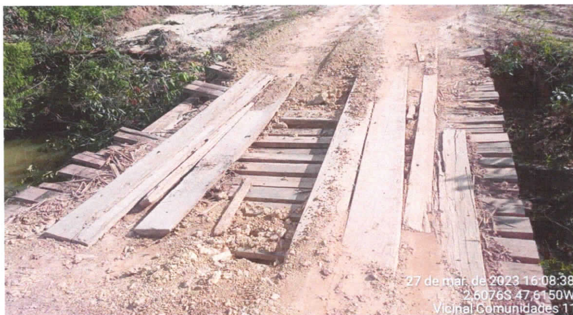
Foto 05 - Corrego na Vicinal Comun. 11 - Tubulação Tb-120
