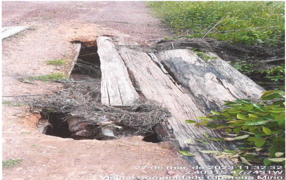
Foto 02 - Corrego na Vicinal Cipoteua Mirim - Tubulação Tb-120
