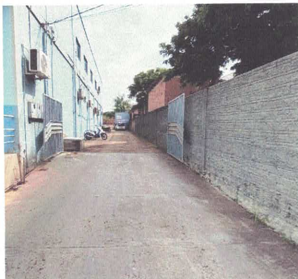
Figura 8: rampa de acesso estacionamento.
