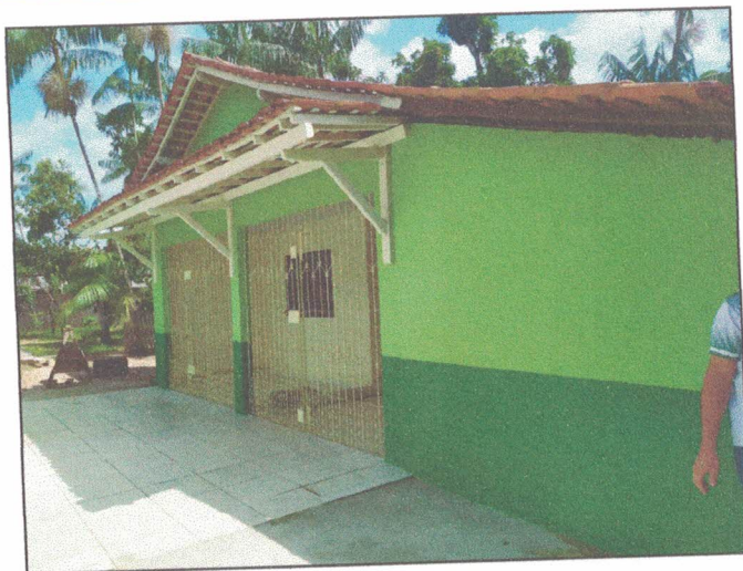
Foto 02: Fachada secundária do imóvel. Fonte: SEPLAN
