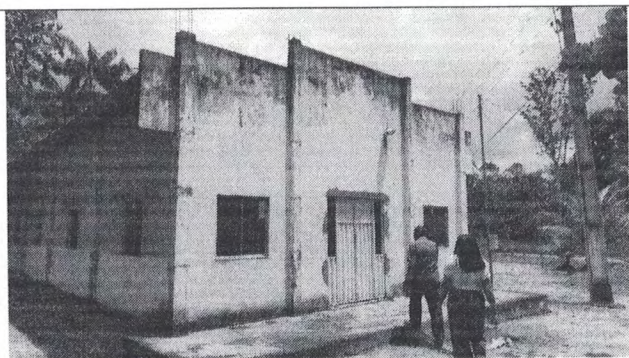
Vista Frontal (Fachada)
