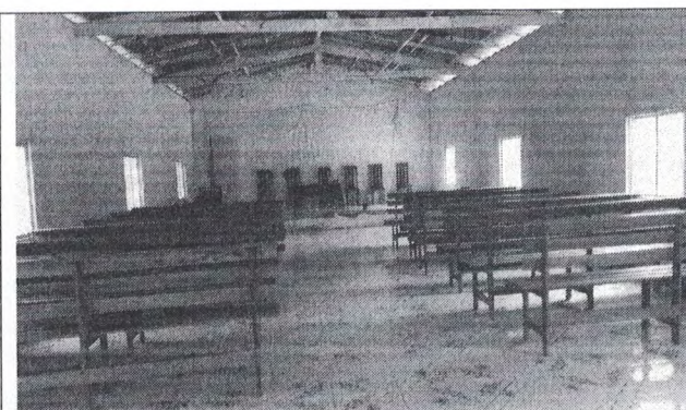
Vista Interna – piso cerâmico
