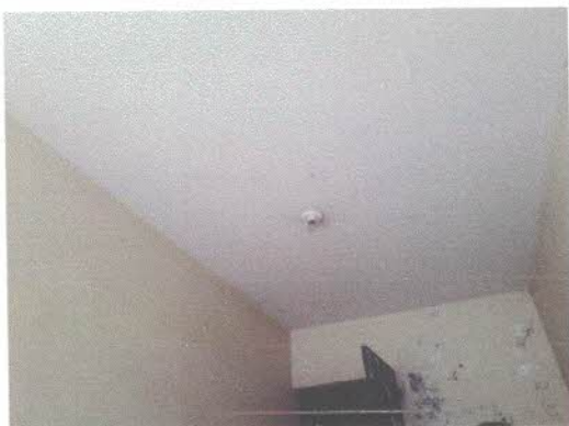
Imagem 4 – Teto em laje com acabamento
