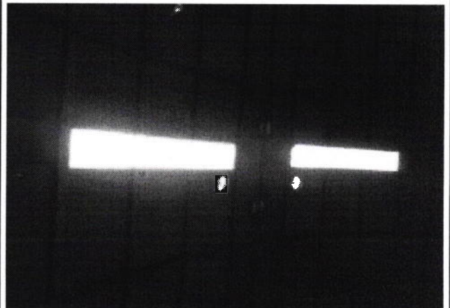
Foto 04 Presença de telhas transparente para clarear o ambiente.
