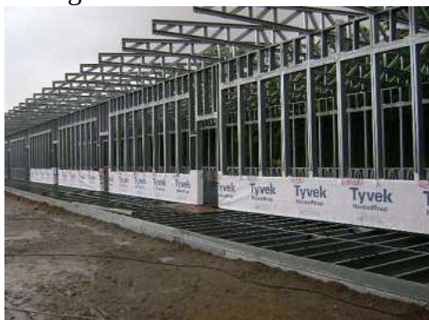
Figura 1 – Instalação pela parte inferior
