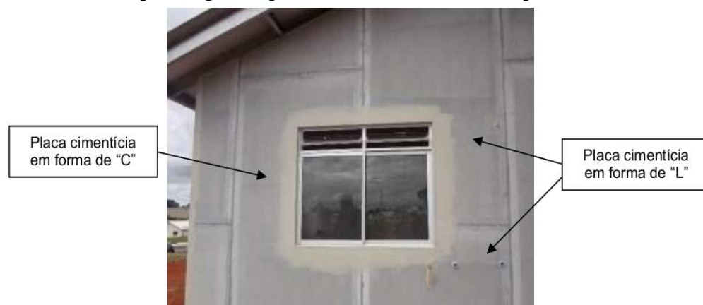
Figura 3 – Paginação das placas cimentícias em aberturas
