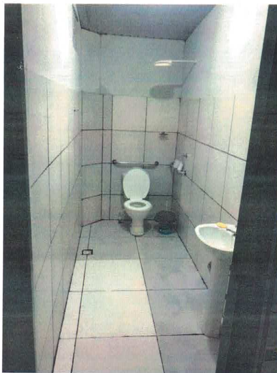
Imagem 10: Banheiro de uso da geral
