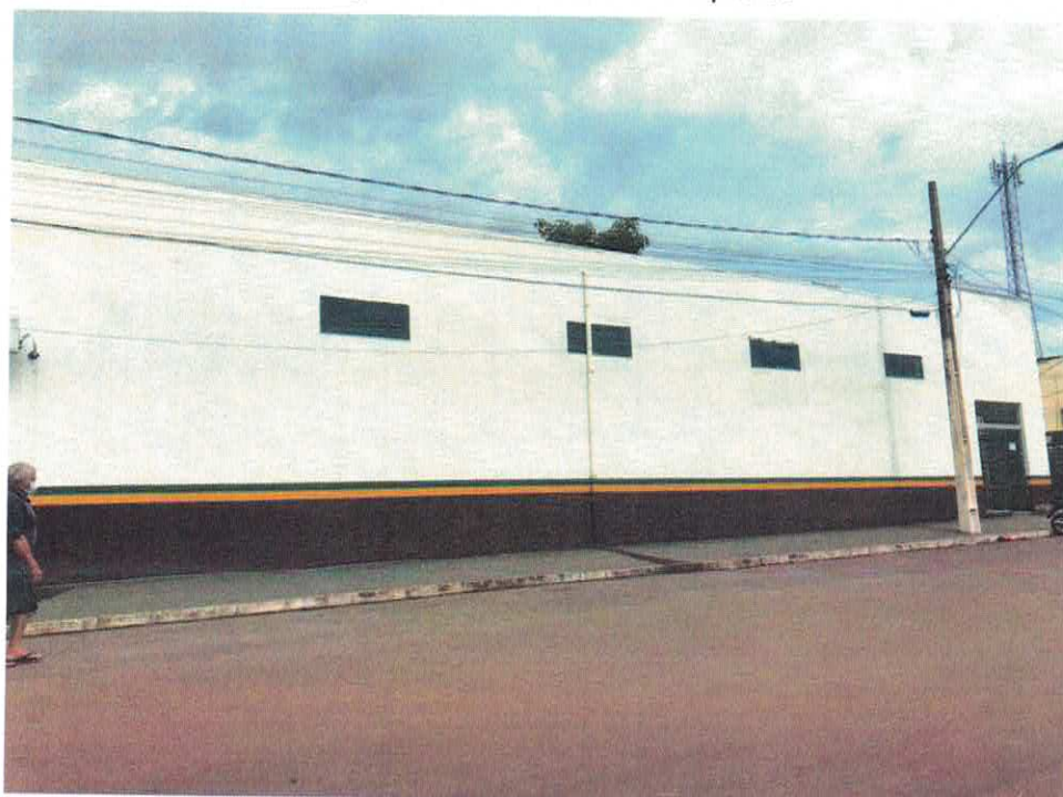
Imagem 02: Fachada lateral esquerda
