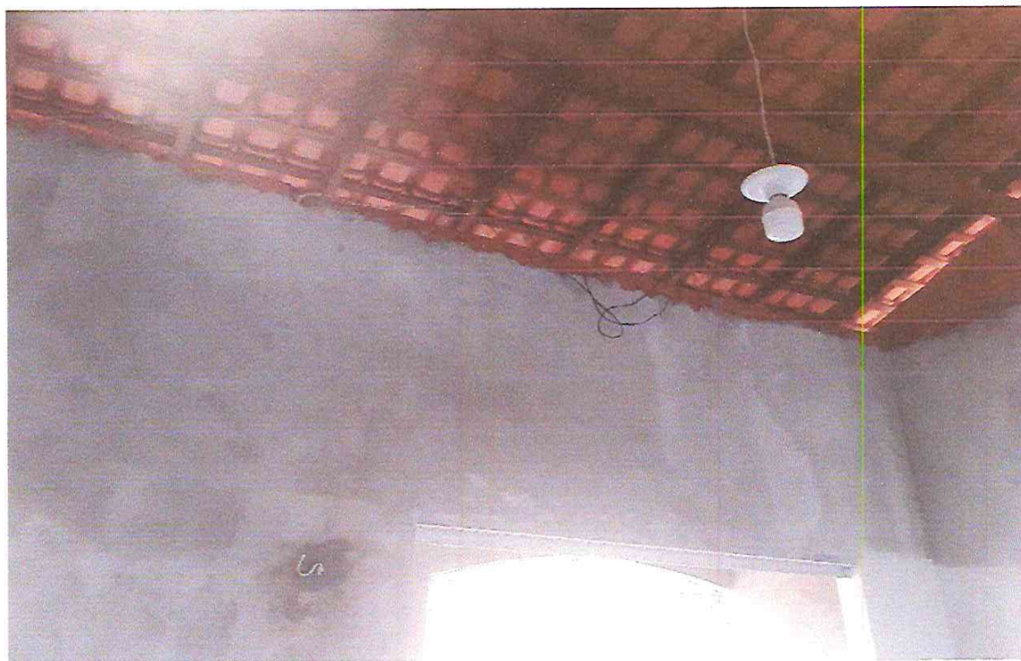
FOTO 06: COBERTURA TELHA CERÂMICA (AMBIENTE NÃO APRESENTA FORRO).
