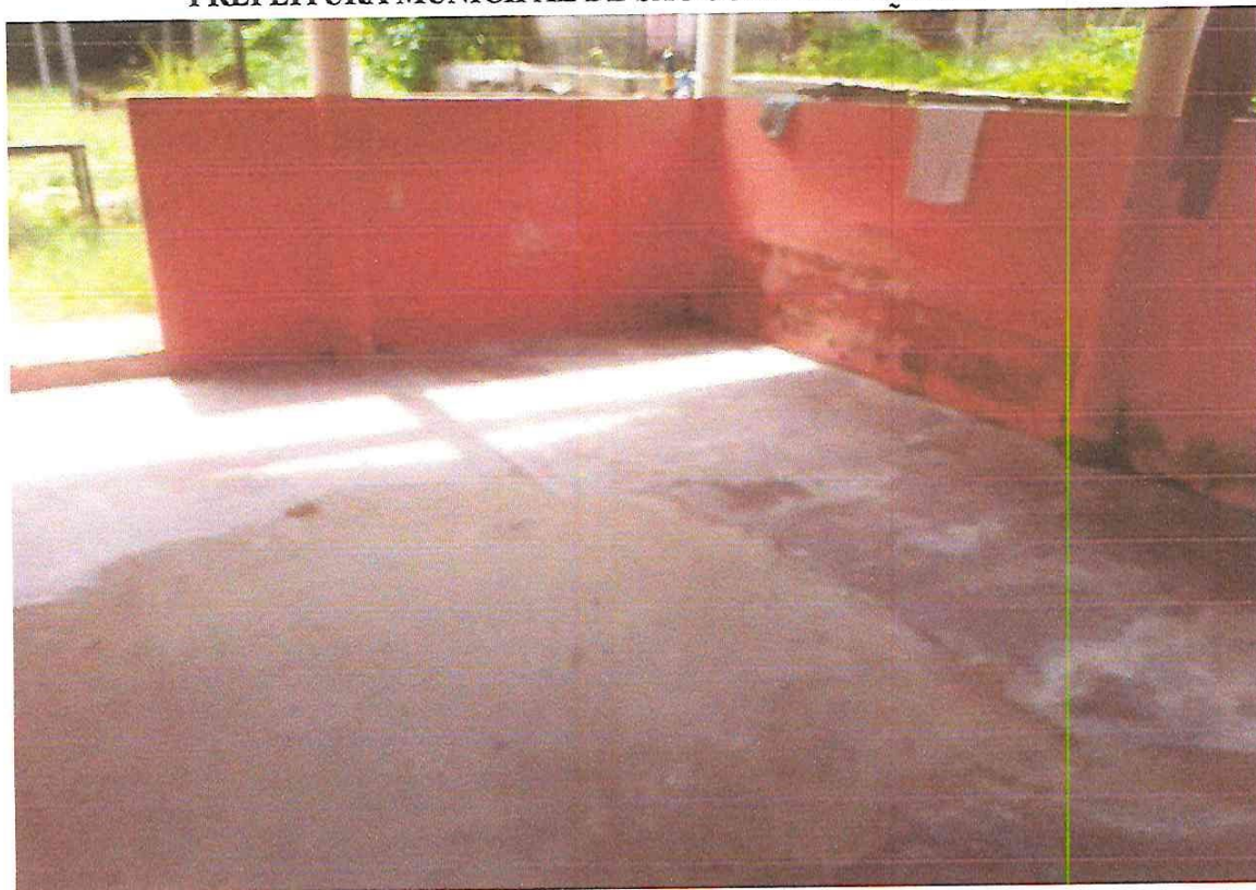
FOTO 09: ÁREA COBERTA – PISO CIMENTADO.
