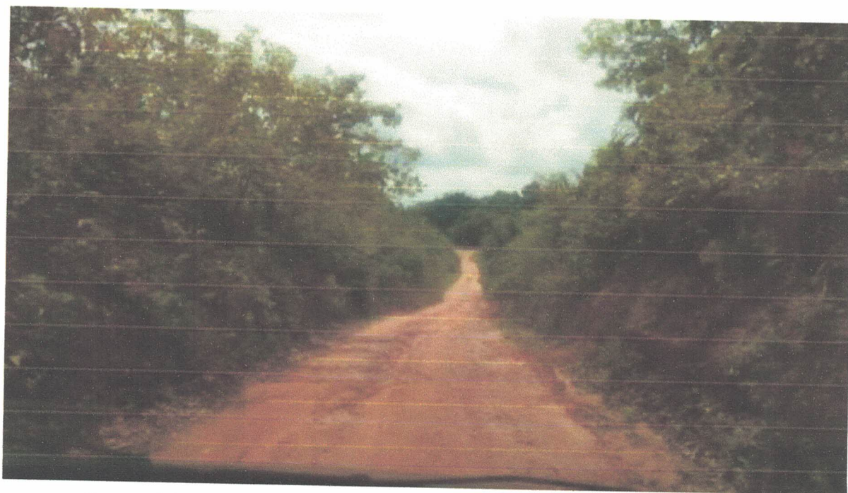
Figura 04: Vicinal Doca, local existente. Fonte: Topografia, Francisco, 2021
