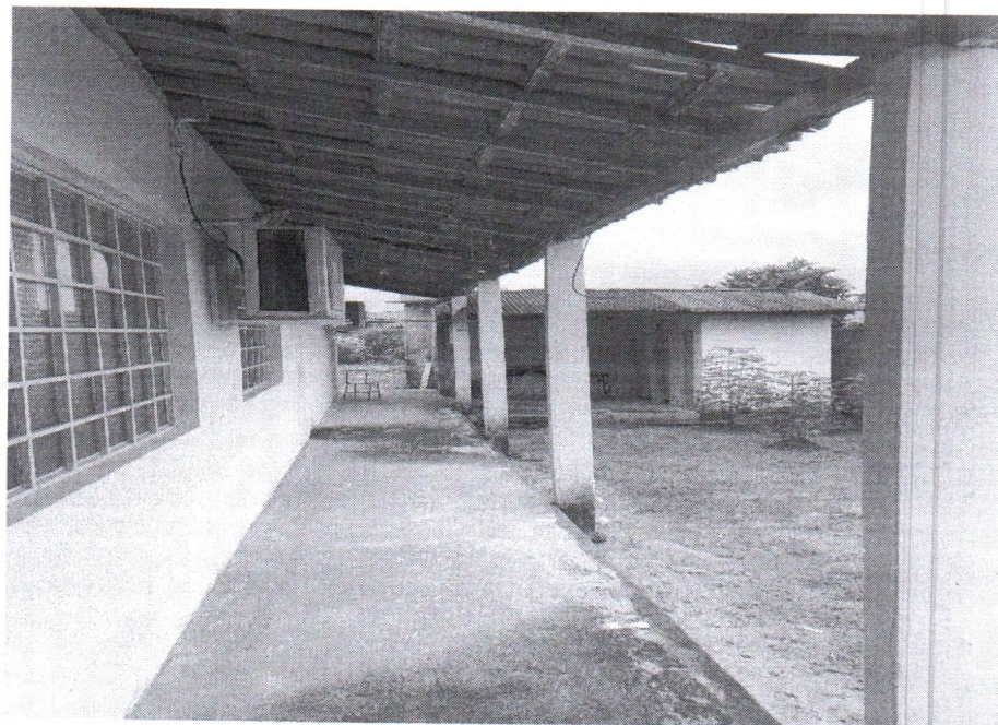
Imagem 02 – Corredor acesso banheiro.
